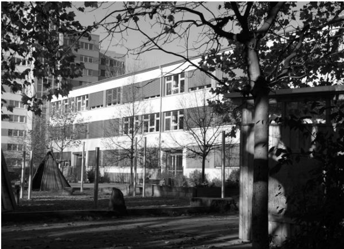
Abbildung 1: Ansicht der 102. Grundschule nach der Sanierung von der Hofseite
