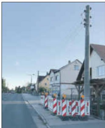
Die Fa. HEF Flottmann baut im Auftrag der DREWAG und der öffentlichen Beleuchtung die oberirdischen Leitungen und die Betonmasten auf ca. 400m entlang der Königsbrücker Landstraße zurück. Die Leitungen wurden bereits mit der Gehwegsanierung verlegt. Nachdem alle Anlieger an das neue DREWAG Elt-Netz angeschlossen sind und gleichzeitig eine moderne Beleuchtungsanlage montiert wurde, kann die Baumaßnahme nunmehr mit dem Rückbau abgeschlossen werden. Weixdorf wird wieder ein Stück moderner.
