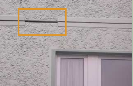
Erhaltung von Fledermausquartieren in einer Plattenfuge durch Weglassen des Fugenbandes bzw. Dichtungsmaterialies
