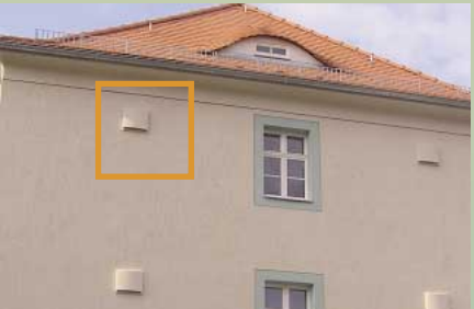
Fledermaus-Fassadenflachkästen auf der Wand montiert
