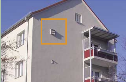
Mauersegler-Doppelhaus in der Wärmedämmung
