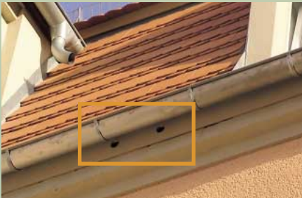
Einflugsöffnungen zu Brutplätzen im Gesimsbereich konstruktiv für Mauersegler
