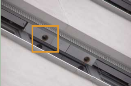
Mauerseglerbrutplätze konstruktiv in einer Fassade
