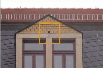
Mauerseglerbrutplatz konstruktiv über Einflug in der Mansarde
