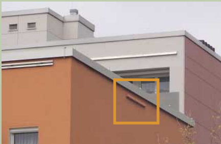
Mauerseglernistkasten in der Wärmedämmung
