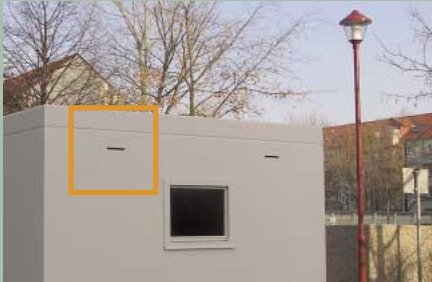
Fledermaus-Einbausteine in der Wärmedämmung
