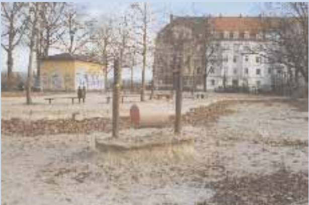
Freiliegende Fundamente, kein Fallschutz
