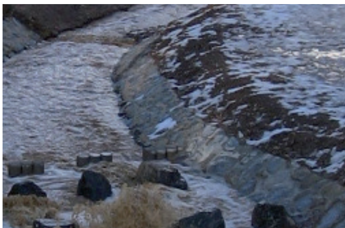
Mit Wasserbausteinen befestigter Auslaufbereich des Hochwasserrückhaltebeckens
