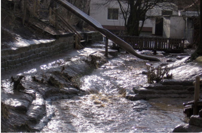
Überflutung und Verschlammung des Spielplatzes Schule Heiliger Born aufgrund eines zugesetzten Rechens
