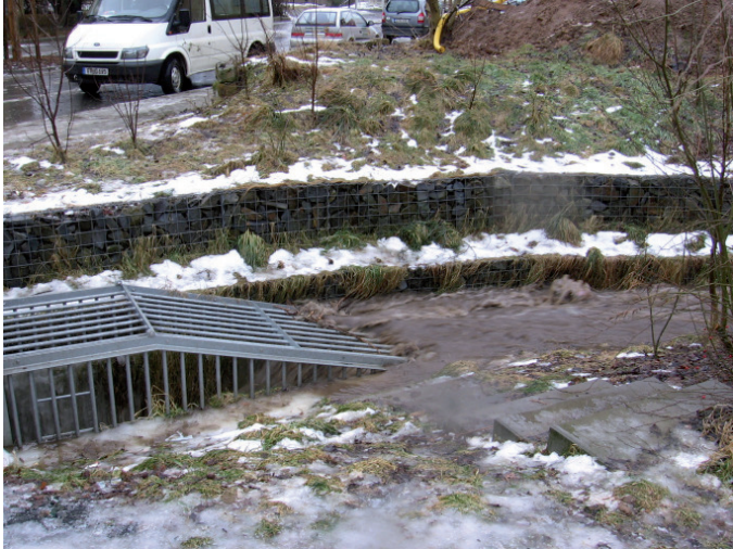
Nach der Beräumung von Unrat und Schwemmgut: Rechen am Beginn der Verrohrung
