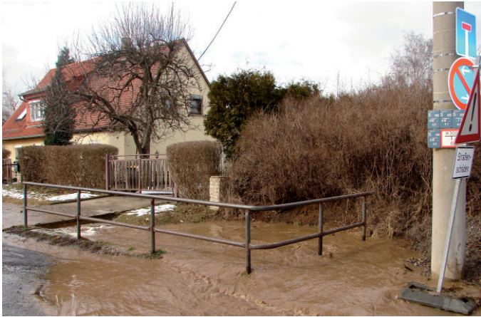
Hydraulische Überlastung des Gompitzer Grabens am Einlauf in die Verrohrung, im Bereich Sanddornstraße
