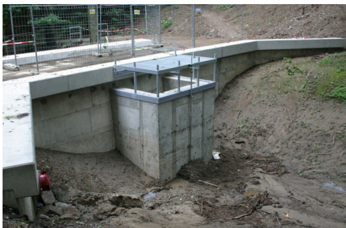
Mit Schlamm zugesetztes Drosselbauwerk am sanierten Hochwasserrückhaltebecken nach dem Starkregenereignis 27. Juni 2006
