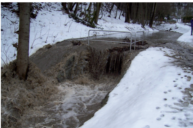
Umströmter Rechen am 17. Februar 2006 aufgrund von hohen Abflussmengen
