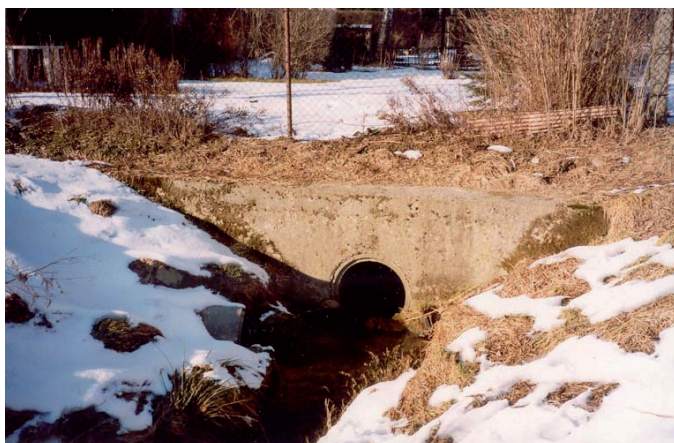
Verrohrung im Bereich Marienbäder Bungalowsiedlung, welche durch die Maßnahme 22x-3010 offengelegt werden soll
