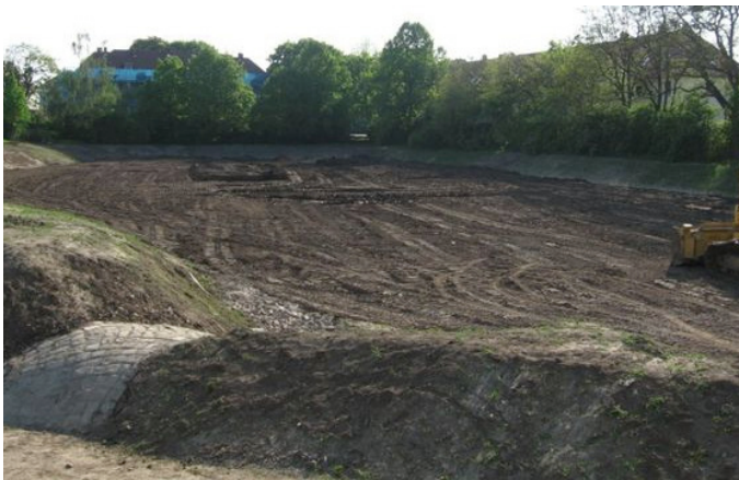
Nach der Erweiterung: Neuer Teil des Hochwasserrückhaltebeckens und mit Wasserbausteinen gesicherter Einlauf
