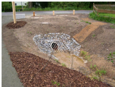
Nach der Offenlegung des 2. Bauabschnittes: Einlauf in die bestehende Verrohrung mit Sedimentfang und Rechen
