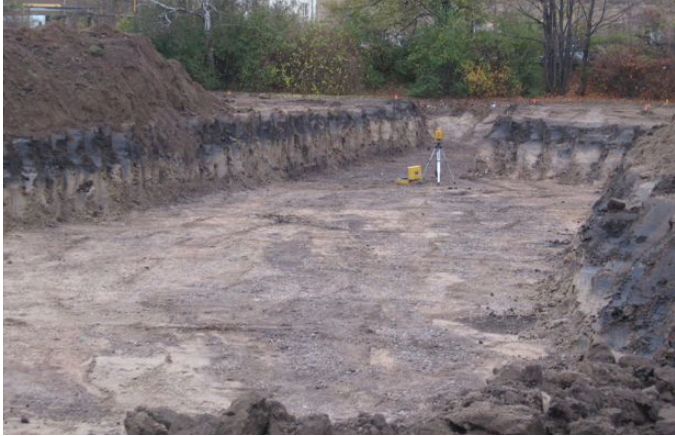
Während der Baumaßnahme: Abtragung von rund 6 000 m³ Erdmassen
