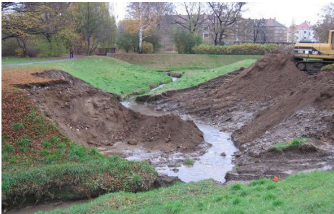
Während der Baumaßnahme: Bereich des neuen Geschiebeund Sedimentfangs
