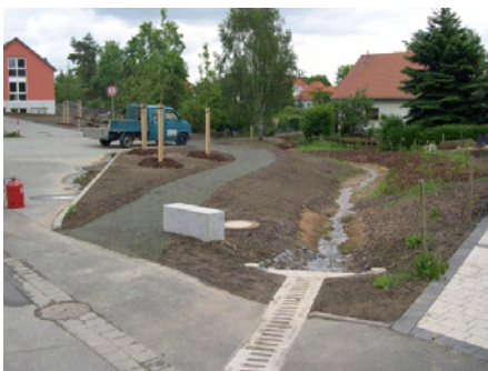
Nach der Offenlegung: Böschungssicherung mit Kokosfaserge-webe (Bauabschnitt 2)
