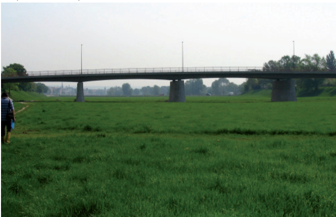
Die neue Sternstraßenbrücke Bildquelle: Landeshauptstadt Dresden, Umweltamt, 2005
