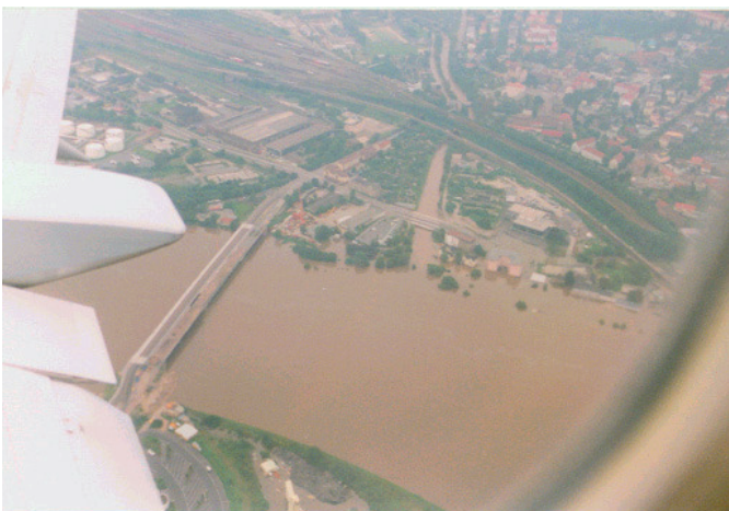
Mündung der Weißeritz während des Hochwassers 2002 Bildquelle: Landeshauptstadt Dresden, Umweltamt, 2002
