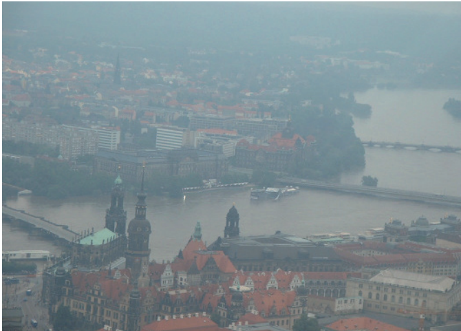
Das Königsufer während des Hochwassers 2002. Bildquelle: Landeshauptstadt Dresden, Umweltamt, 2002
