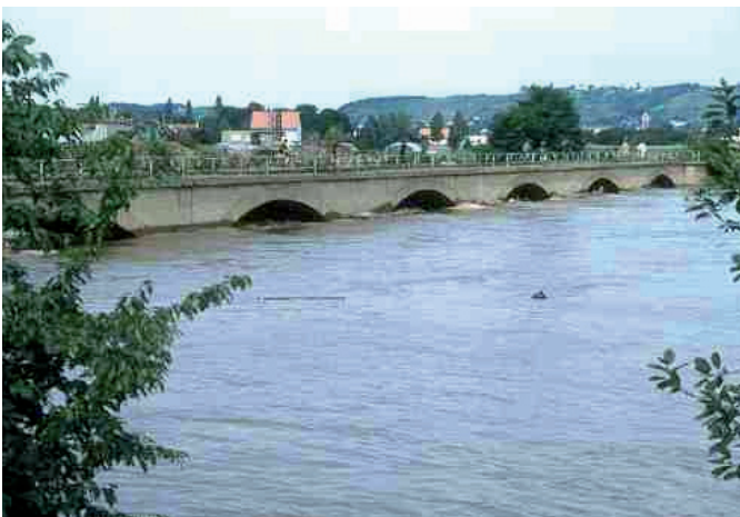
Die Eisenbahnbrücke über die Flutrinne Kaditz während des Hochwassers 2002 Bildquelle: www.sachsenschiene.de , Jens Herbach, 2002
