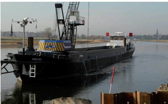
Schwimmbagger bei der Beseitigung der Sedimente Bildquelle: Wasser- und Schifffahrtsamt Dresden, 2005
