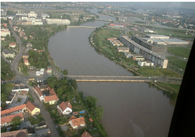
Sternstraßenbrücke über die Flutrinne Kaditz während des Hochwassers 2002 Bildquelle: Landeshauptstadt Dresden, Umweltamt, 2002
