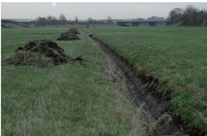
Abzugsgraben nach der Reinigung Bildquelle: Landeshauptstadt Dresden, Umweltamt, 2006
