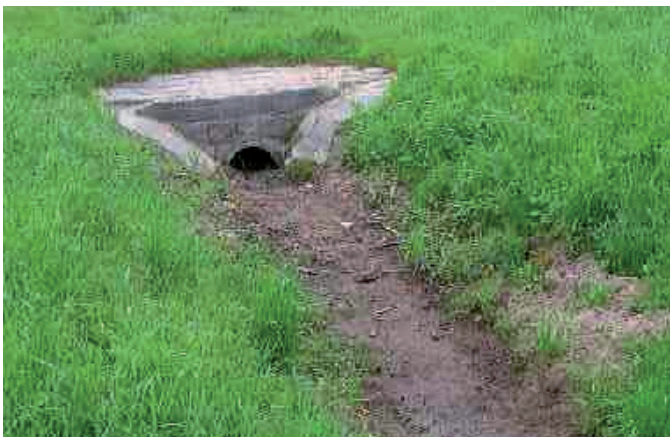
Ablagerung von Sedimenten im Abzugsgraben Bildquelle: Landeshauptstadt Dresden, Umweltamt, 2006
