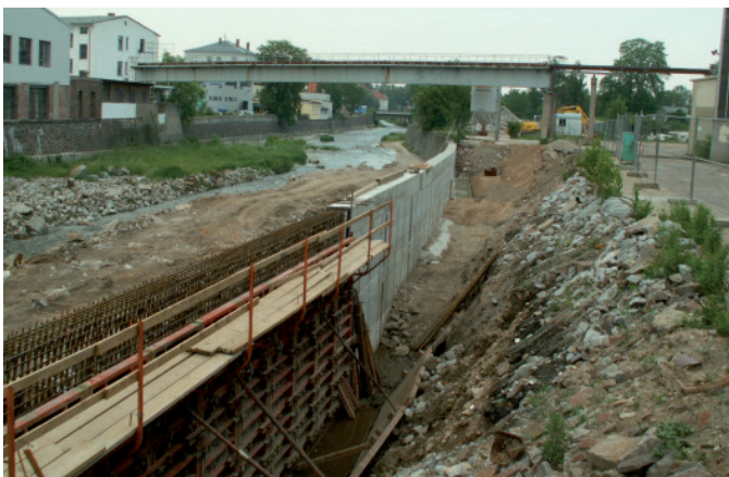
Der Neubau der Ufermauer Bildquelle: Landeshauptstadt Dresden, Umweltamt, 2007
