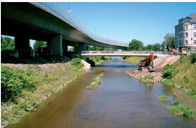
Abschließende Arbeiten an der neuen Brücke Bildquelle: Landeshauptstadt Dresden, Umweltamt, 2007
