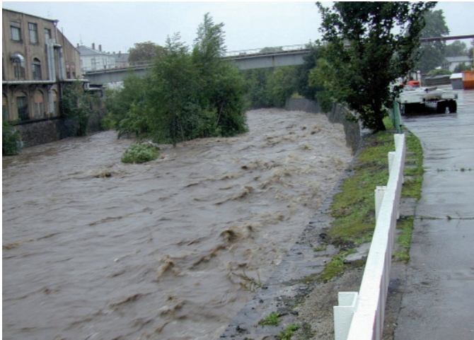
Die Ufermauer während des Hochwassers 2002 Bildquelle: Maschinen- und Stahlbau Dresden GmbH, 2002
