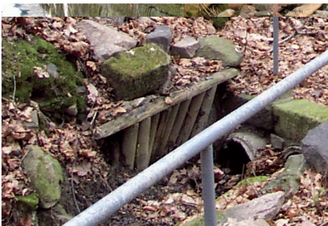
Vor der Hochwasserschadensbeseitigung: Zugesezte und teilweise zerstörte Wegquerung
