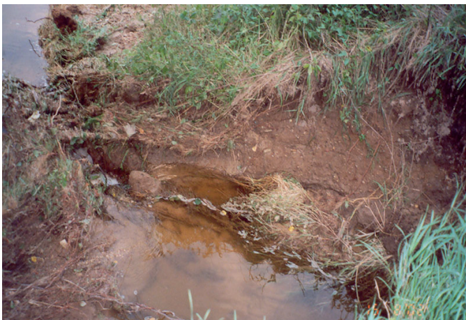
Vor der Hochwasserschadensbeseitigung: beschädigte Uferböschung, Dammdurchbruch
