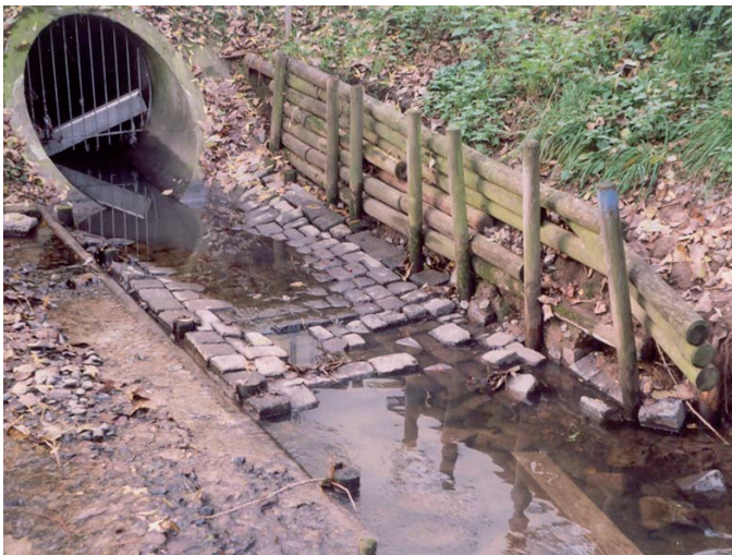
Vor der Hochwasserschadensbeseitigung: Beschädigte Böschungsbefestigung
