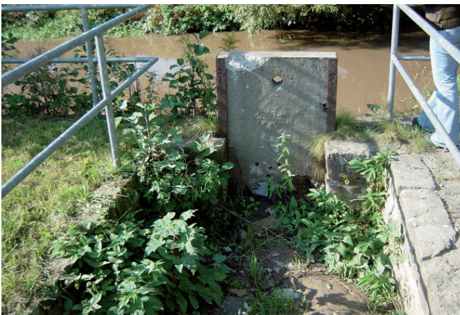
Vor der Hochwasserschadensbeseitigung: Einlaufbauwerk des Zulaufgrabens aus dem Lockwitzbach
