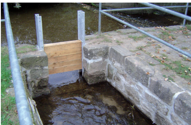
Nach der Hochwasserschadensbeseitigung: Einlaufbauwerk des Zulaufgrabens aus dem Lockwitzbach
