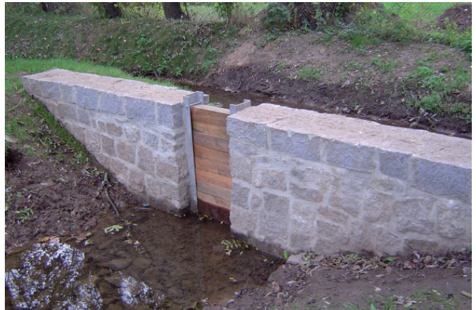
Nach der Hochwasserschadensbeseitigung: Einlaufbauwerk in die Dankelmannteiche
