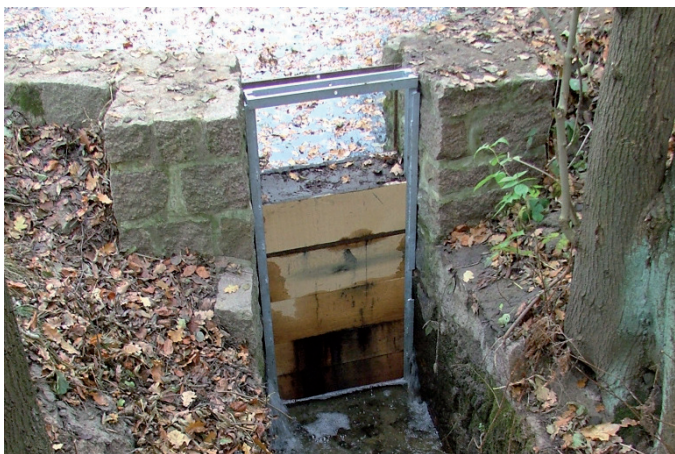
Nach der Hochwasserschadensbeseitigung: Neuerrichteter Schütz
