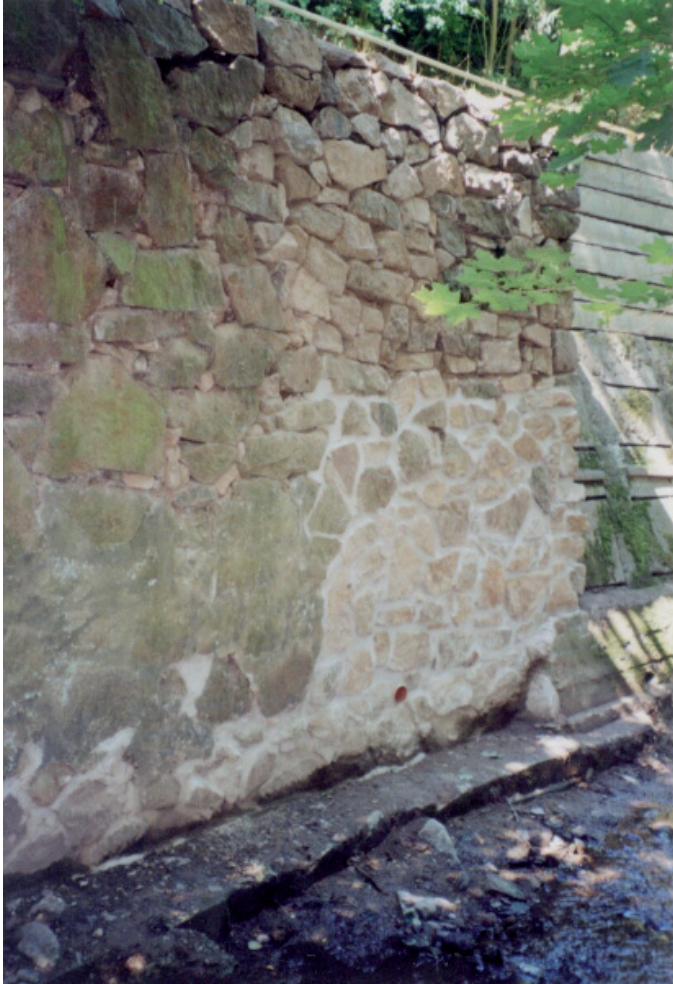
Nach der Hochwasserschadensbeseitigung: Wiederhergestellte Ufermauer
