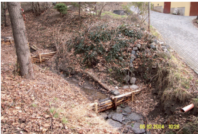
Vor der Hochwasserschadensbeseitigung: Auskolkungen an der Uferböschung
