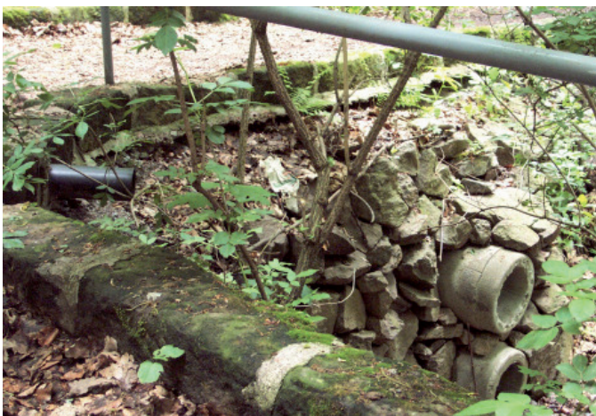
Vor der Hochwasserschadensbeseitigung: Verrohrung des Wededamms
