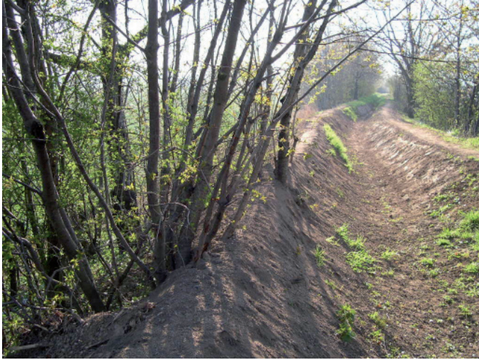
Nach der Hochwasserschadensbeseitigung: Wiederhergestellter Damm und profilierte Böschung
