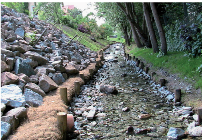
Nach der Hochwasserschadensbeseitigung: Wiederhergestelltes Gewässerbett
