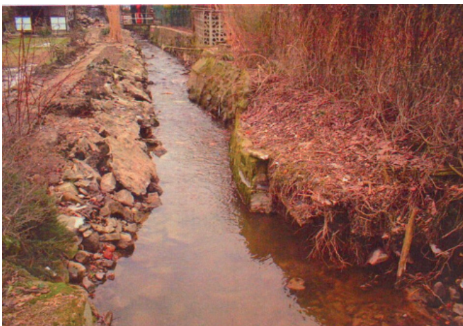
Vor der Hochwasserschadensbeseitigung: beschädigte Böschung und Ufermauer
