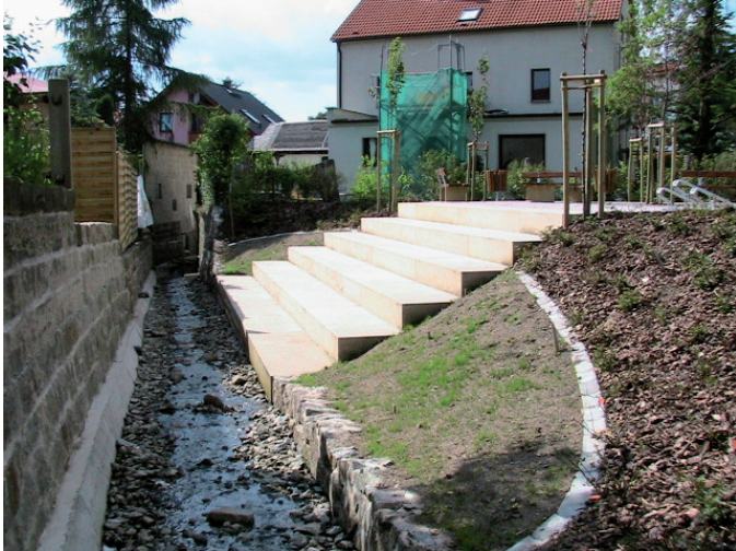
Nach der Hochwasserschadensbeseitigung: Wiederhergestelltes Gewässerbett und abgestufte Böschung
