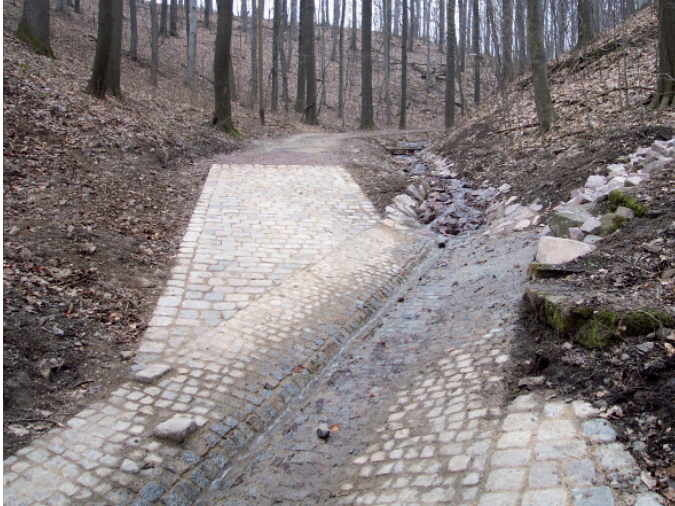
Nach der Hochwasserschadensbeseitigung: Neugebaute Furt zur Wegquerung
