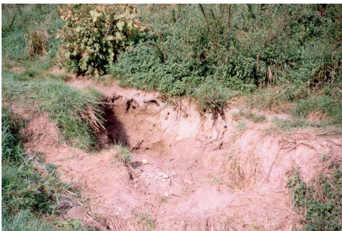
Vor der Hochwasserschadensbeseitigung: Schäden an der Böschung
