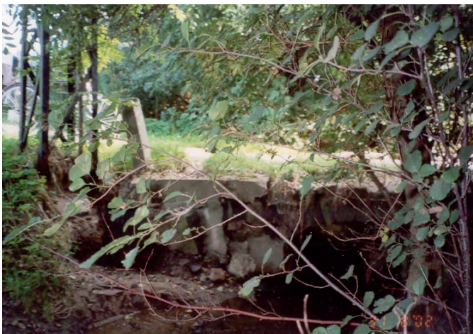
Vor der Hochwasserschadensbeseitigung: Böschungsruutschen
