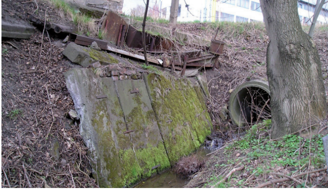
Vor der Hochwasserschadensbeseitigung: beschädigte Böschung mit Verrohrung
