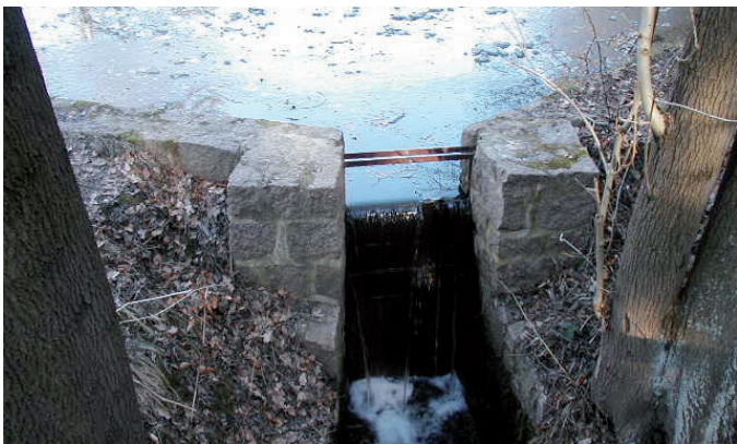
Vor der Hochwasserschadensbeseitigung: Der zu ersetzende Mönch
