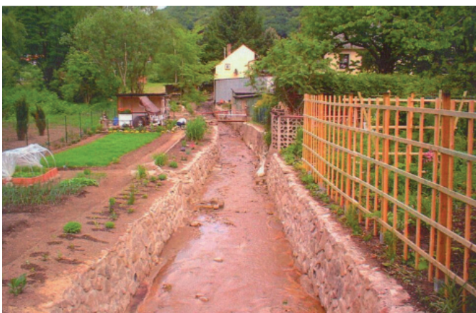
Vor der Hochwasserschadensbeseitigung: Massive Schäden am Gewässerbett und den Ufermauern
