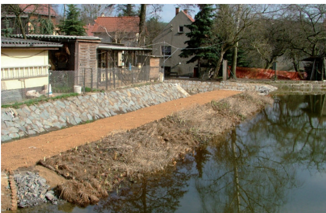
Nach der Hochwasserschadensbeseitigung: Neuer Teichdamm
