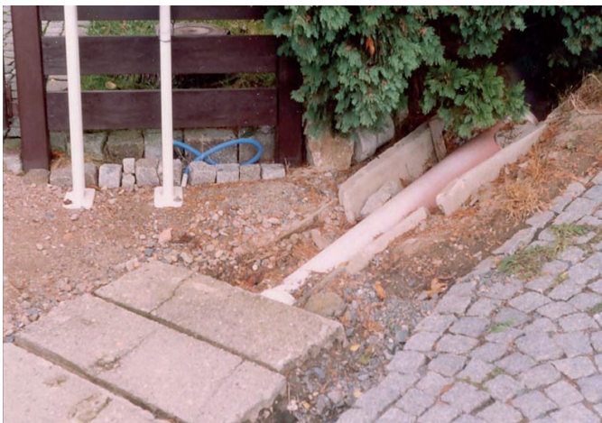
Vor der Hochwasserschadensbeseitigung: Vorhandene im August 2002 hydraulisch überlastete Verrohrung
