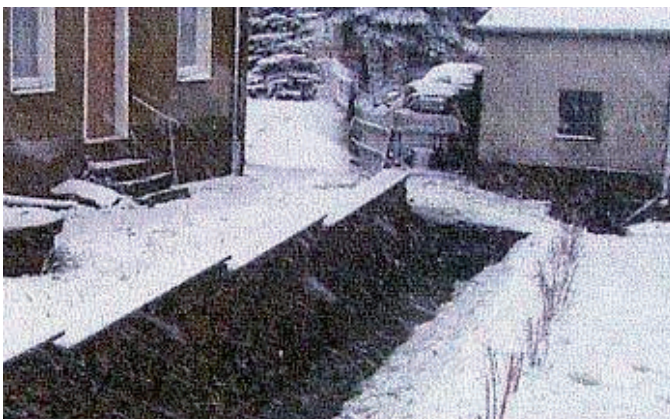
Nach der Schadensbeseitigung; Instandgesetzte Ufermauer und vollständig offengelegter Bachabschnitt
