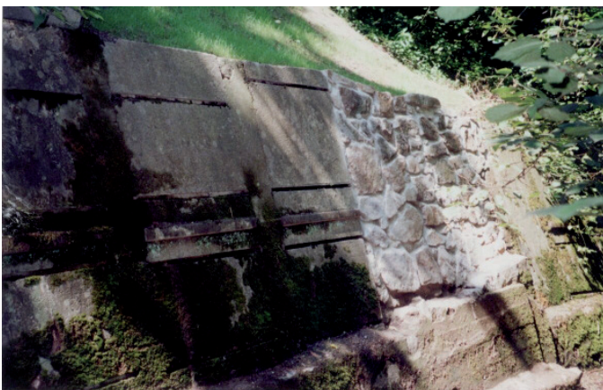
Nach der Hochwasserschadensbeseitigung: Wiederhergestellte Ufermauer mit profilierter und gesicherter Böschung
