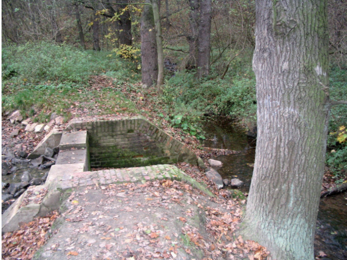
Nach der Hochwasserschadensbeseitigung: Erneueres bzw. neugebautes Auslaufbauwerk
