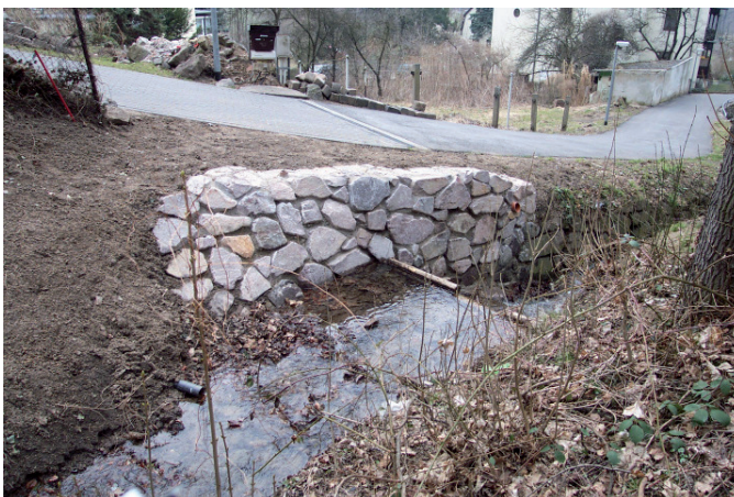
Vor der Hochwasserschadensbeseitigung: Durch Steinsatz gesicherte Uferböschung
