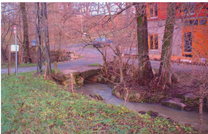
Nach der Hochwasserschadensbeseitigung: Teilweise Offengelegte, neu profilierte und gesicherte Böschung
