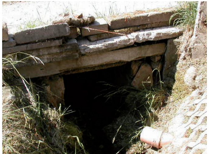
Vor der Hochwasserschadensbeseitigung: Mangelhafter Durchlass
