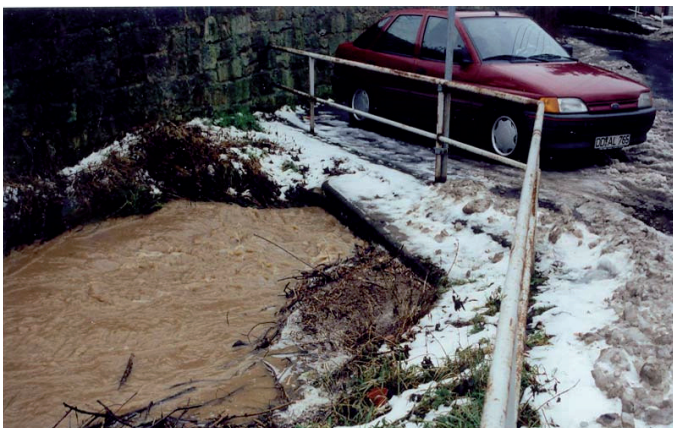
Vor der Hochwasserschadensbeseitigung: Hydraulisch überlastete Brücke während des Winterhochwassers 2003/2004
