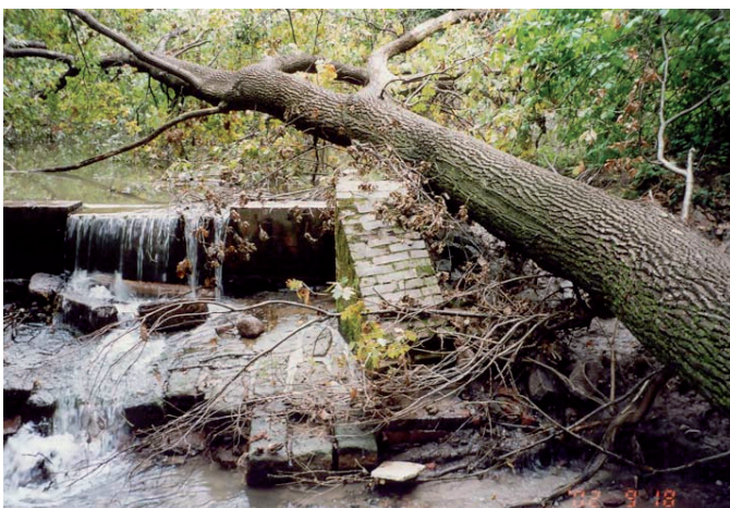
Vor der Hochwasserschadensbeseitigung: Beschädigtes Auslaufbauwerk
