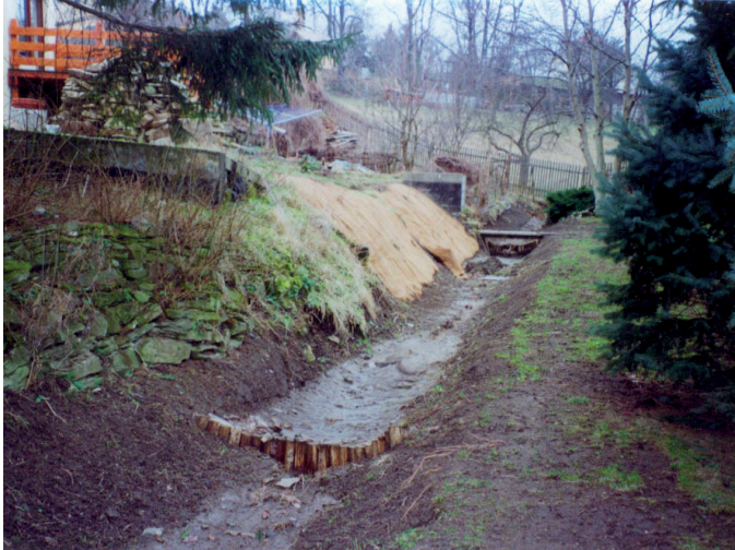
Nach der Hochwasserschadensbeseitigung: geräumtes Abflussprofil mit Querriegeln zur Sohlsicherung
