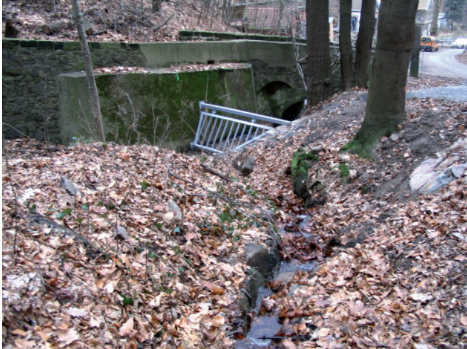
Nach der Hochwasserschadensbeseitigung: Neu errichteter Geschiefefang
