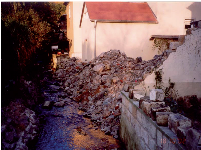
Vor der Hochwasserschadensbeseitigung: eingestütztes Mauerwerk
