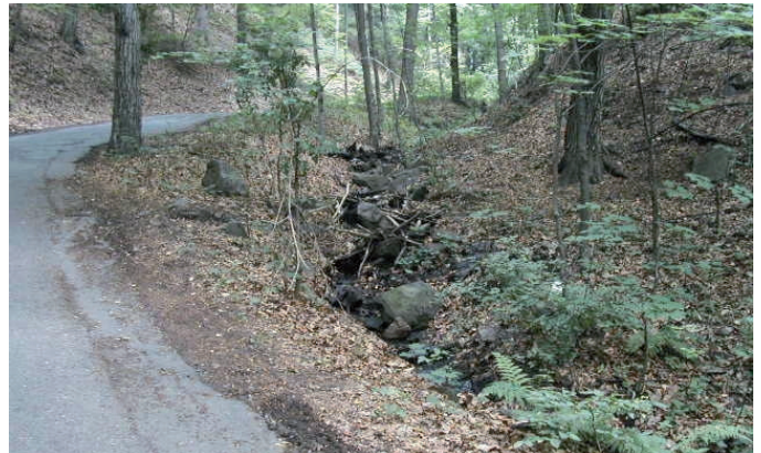
Vor der Hochwasserschadensbeseitigung: Blick entlang Malschendorfer Graben, massive Geschiebeablagerungen, hochgelegene, gepflasterte Grabensohle
