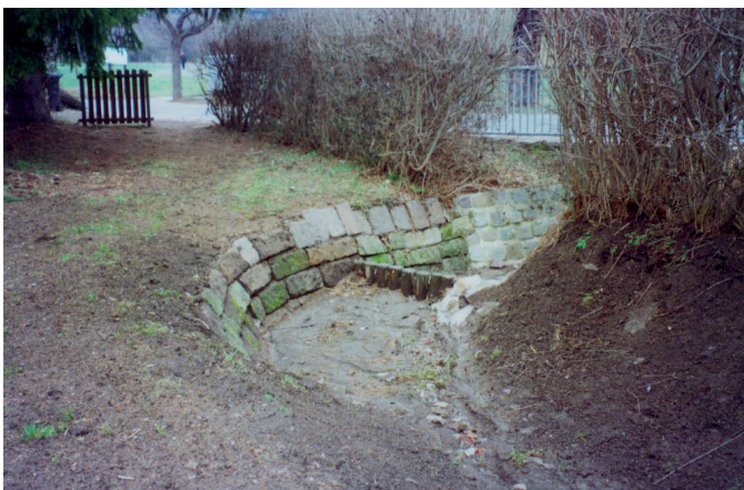
Nach der Hochwasserschadensbeseitigung: mit Wasserbausteinen gesicherte Uferböschung
