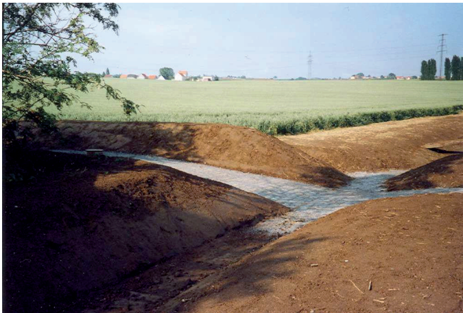
Nach der Hochwasserschadensbeseitigung: Neu errichtete Furt
