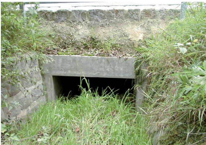
Vor der Hochwasserschadensbeseitigung: zugesetztes Abflussprofil mit Aufwuchs
