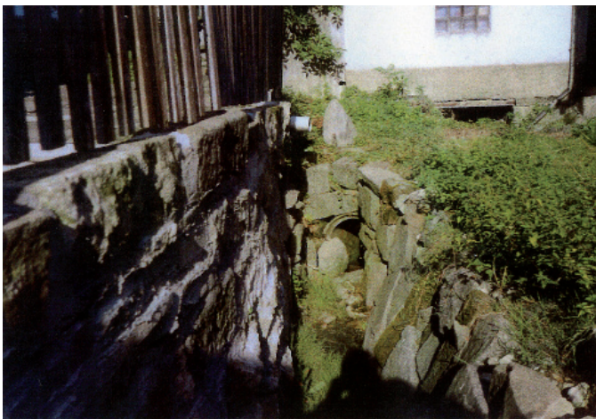
Vor der Schadensbeseitigung; Beschädigte Ufermauer, zerstörte Verrohrung sowie bereits entfernter Hühnerstall
