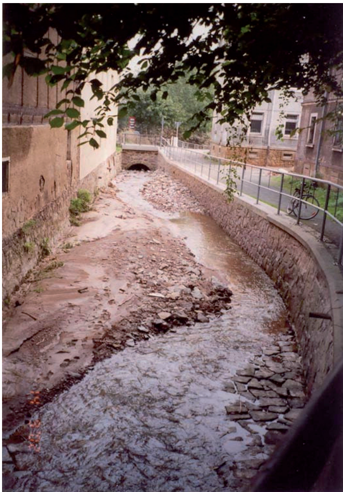
Vor der Hochwasserschadensbeseitigung: Sedimentation im Abflussprofil mit beschädigter Sohlsicherung
