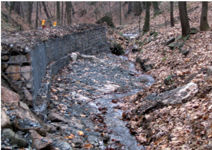
Nach der Hochwasserschadensbeseitigung: Blick entlang Malschendorfer Graben, gesicherte Böschung
