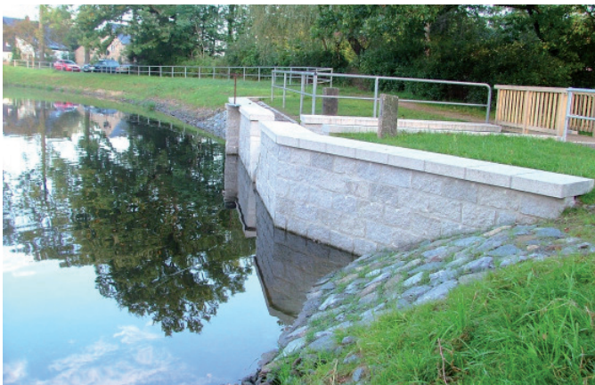
Nach der Hochwasserschadensbeseitigung: Neugebautes Ablaufbauwerk und sanierte Ufermauer
