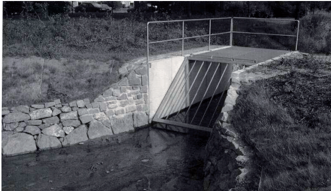
Nach der Hochwasserschadensbeseitigung: Neuerrichtetes Rechenbauwerk
