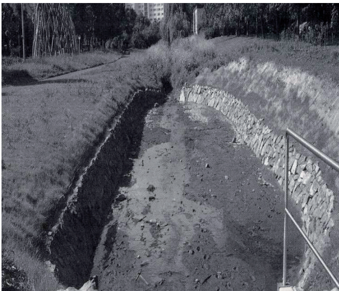
Nach der Hochwasserschadensbeseitigung: Für den Hochwasserrückhalt aufgeweitetes Bachbett
