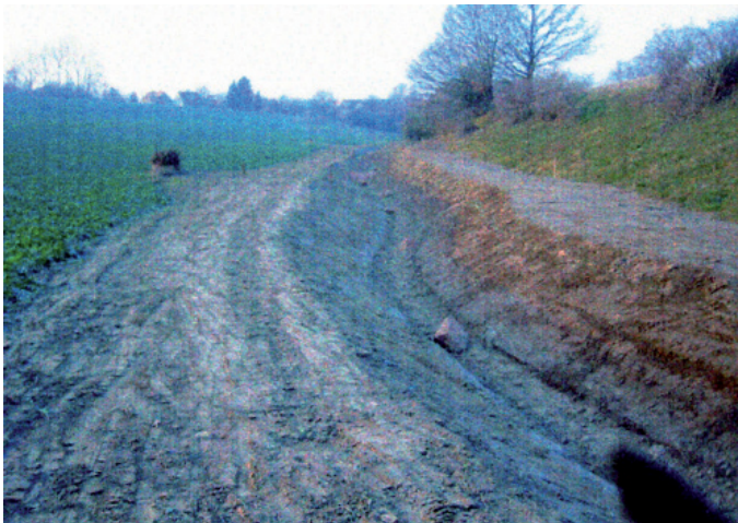
Nach der Hochwasserschadensbeseitigung: profiliertes Bachbett
