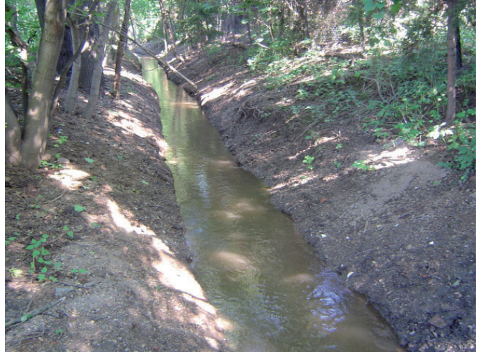
Nach der Hochwasserschadensbeseitigung: Beräumter und wiederhergestellter Gewässerabschnitt
