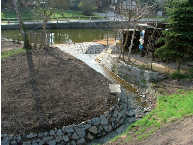
Nach der Hochwasserschadensbeseitigung: Neugebaute Überlaufschwelle und Ufermauer
