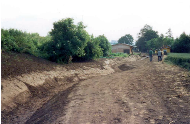
Nach der Hochwasserschadensbeseitigung: Beräumter und profilierter Gewässerabschnitt
