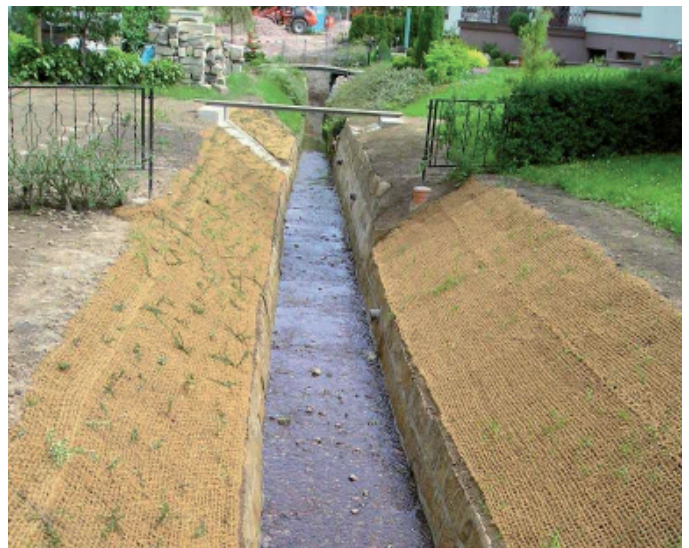
Nach der Hochwasserschadensbeseitigung: wiederhergestellte und gesicherte Uferböschung
