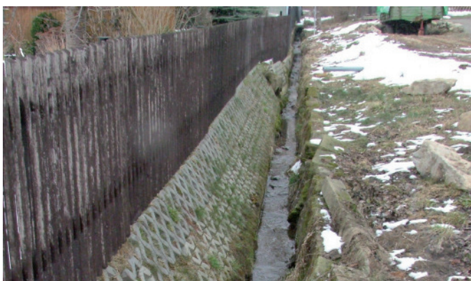
Vor der Hochwasserschadensbeseitigung: Beschädigte Böschung
