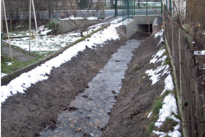
Nach der Hochwasserschadensbeseitigung: Aufgeweitetes Gewässerprofil und neugebauter Durchlass
