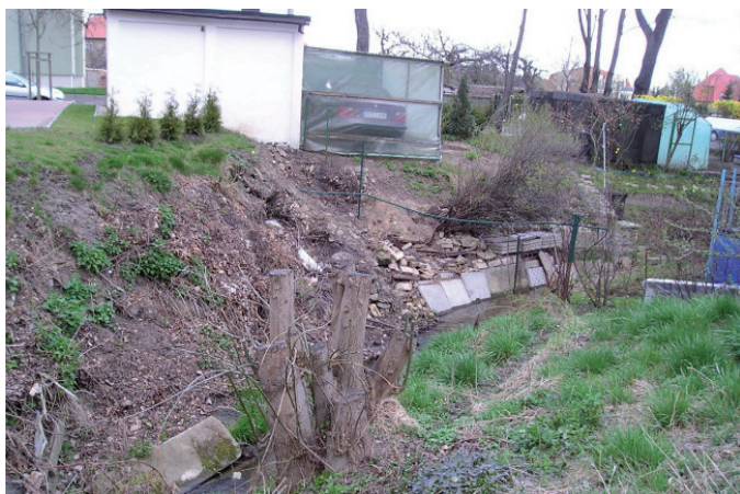
Vor der Hochwasserschadensbeseitigung: beschädigte Böschung
