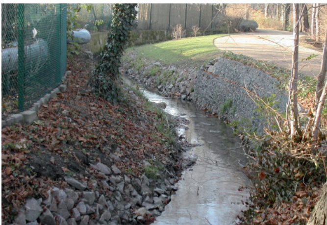
Nach der Hochwasserschadensbeseitigung: Naturnah gesicherte Uferböschung
