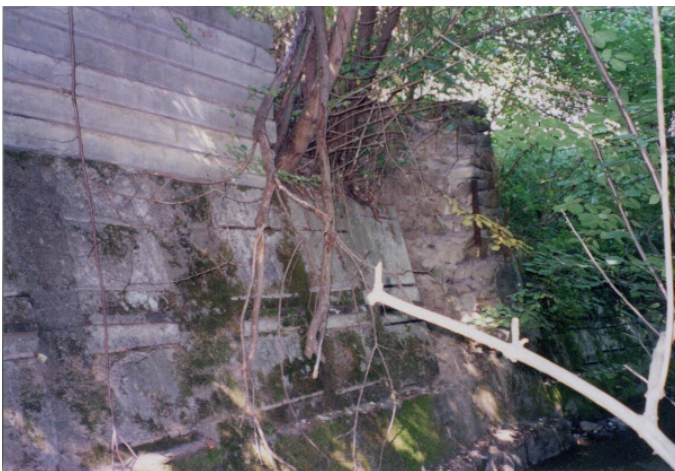
Vor der Hochwasserschadensbeseitigung: Aus der Ufermauer wachsendes Strauchwerk
