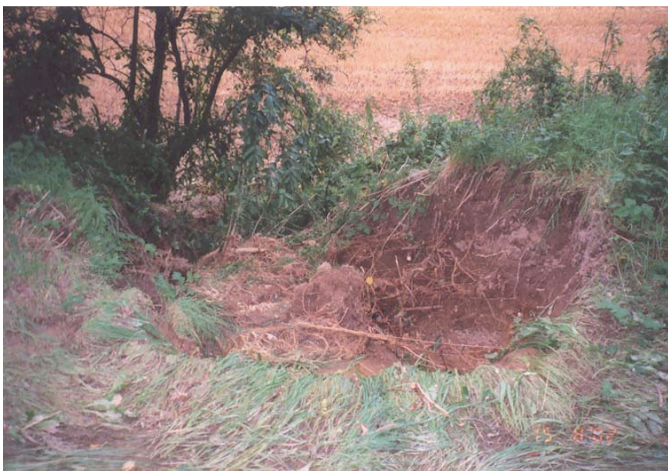
Vor der Hochwasserschadensbeseitigung: beschädigte Uferböschung, Dammdurchbruch
