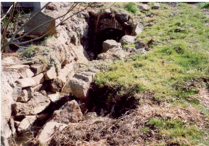
Vor der Hochwasserschadensbeseitigung: zerstörte Mauer
