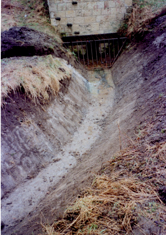
Nach der Hochwasserschadensbeseitigung: beräumtes Abflussprofil mit instandgesetzter Uferböschung
