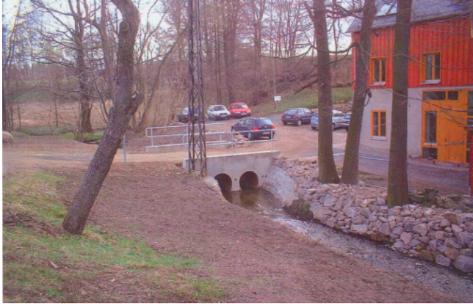
Nach der Hochwasserschadensbeseitigung: gesicherte Böschung mit neugebautem Durchlass
