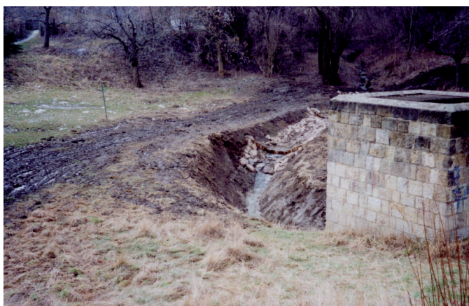
Nach der Hochwasserschadensbeseitigung: geräumtes Abflussprofil mit Sohlgleite im Hintergrund
