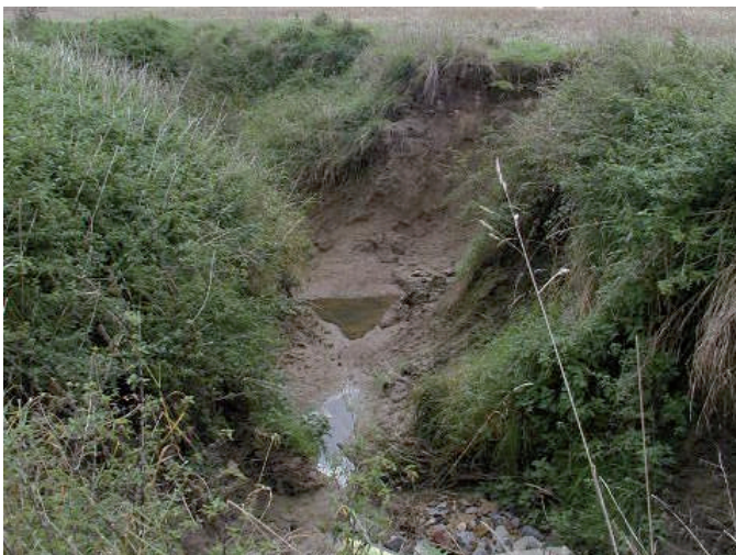
Vor der Hochwasserschadensbeseitigung: Stark beschädigte Böschung
