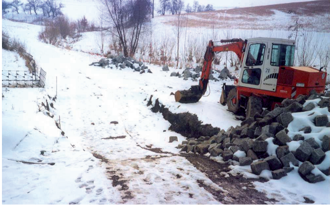
Während der Hochwasserschadensbeseitigung: Herstellung einer neuen Furt
