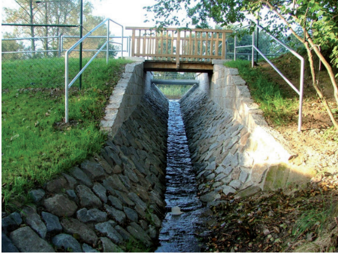
Nach der Hochwasserschadensbeseitigung: Sanierter Auslaufbereich des Nixenteichs
