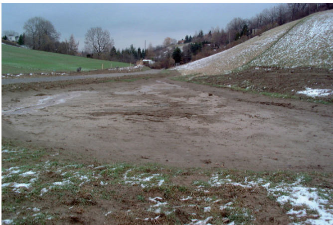
Vor der Hochwasserschadensbeseitigung: Bodenlagerungen im Bereich des geplanten Absetzbeckens
