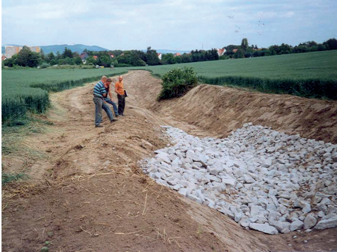
Nach der Hochwasserschadensbeseitigung: Neugebaute Rampe aus Wasserbausteinen
