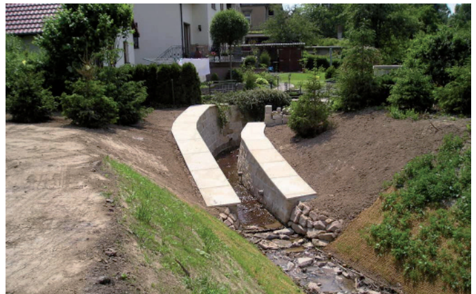
Nach der Hochwasserschadensbeseitigung: Neubau Ufermauer am Beginn des offengelegten Bachabschnittes
