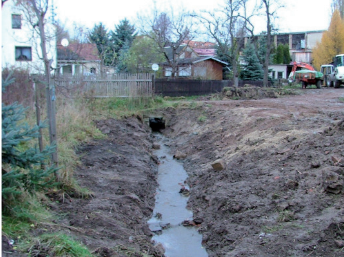
Vor der Hochwasserschadensbeseitigung: Ungenügender Durchlass oberhalb Sandweg
