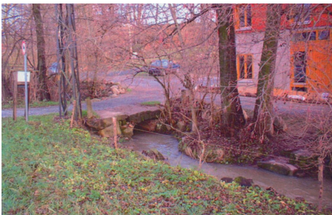
Vor der Hochwasserschadensbeseitigung: beschädigte Böschung mit provisorisch gesichertem Durchlass und Schwemmgutablagerungen im November 2002
