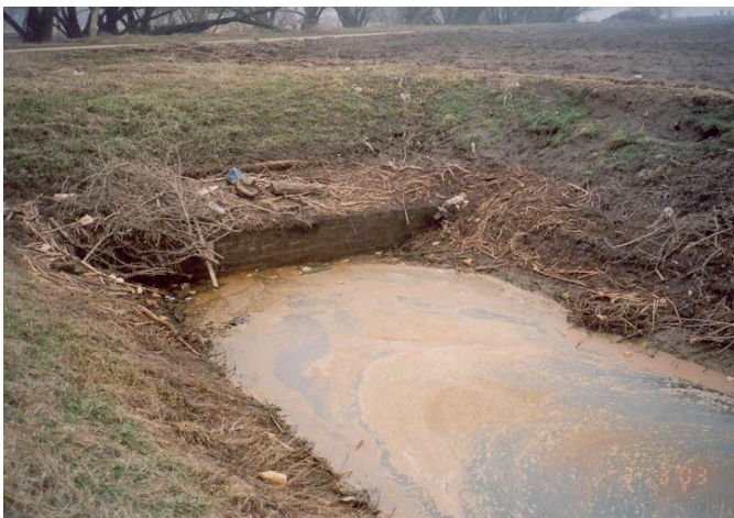
Vor der Hochwasserschadensbeseitigung: starke Sedimentationsablagerungen verstopfen den Durchlass
