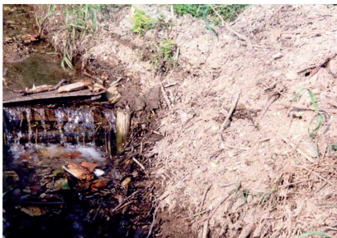
Vor der Hochwasserschadensbeseitigung: Sedimentation im Abflussprofil mit beschädigter Sohle
