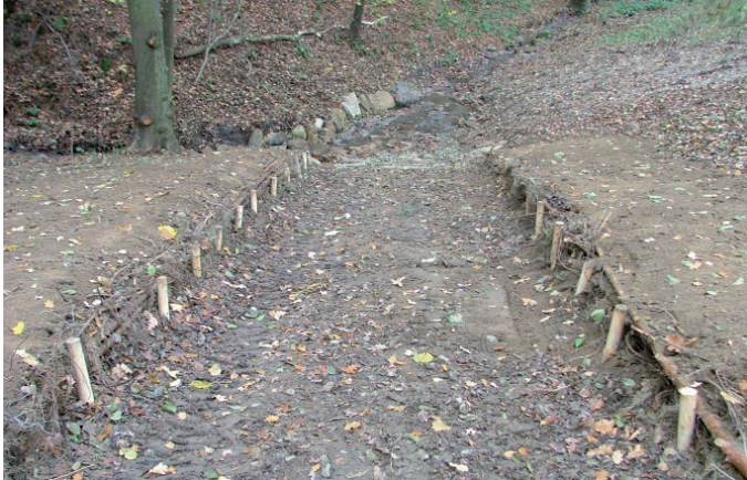
Nach der Hochwasserschadensbeseitigung: Überlaufrinne zur Hochwasserentlastung
