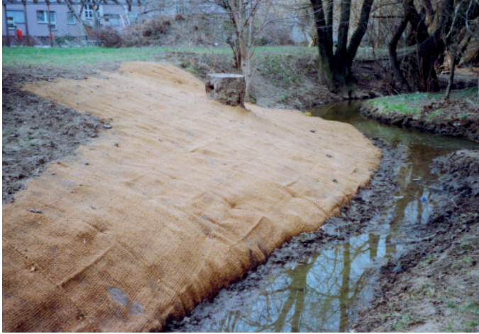
Nach der Hochwasserschadensbeseitigung: Mit Erosionsschutzmatten gesicherte Böschung
