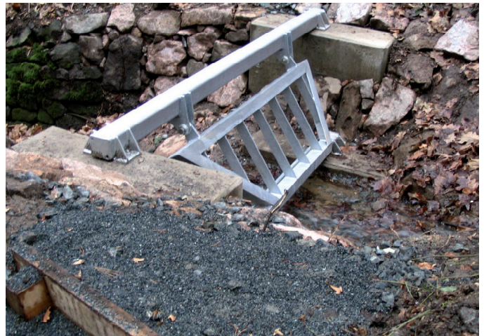
Nach der Hochwasserschadensbeseitigung: Zweiter neu errichteter Geschiefefanggelegene, gepflasterte Grabensohle
