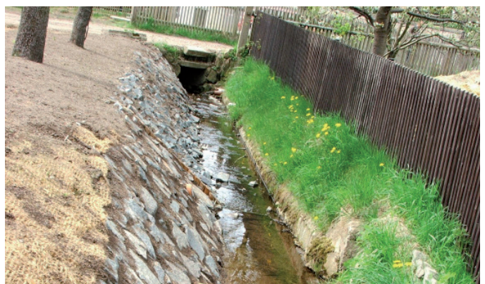
Nach der Hochwasserschadensbeseitigung: Wiederhergestellte und gesicherte Böschung
