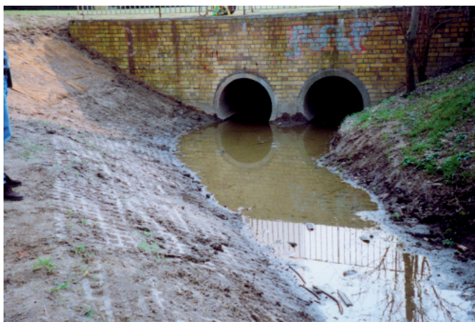
Nach der Hochwasserschadensbeseitigung: Profilierte und gesicherte Böschung
