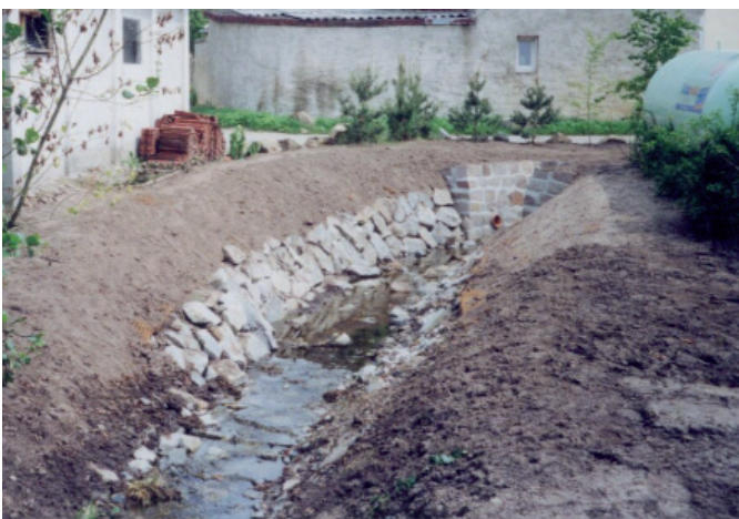
Nach Hochwasserschadensbeseitigung: wiederhergestellte Böschung und Ufermauer
