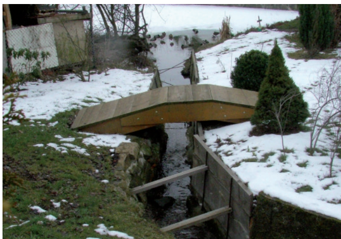
Vor der Hochwasserschadensbeseitigung: Beidseitig Böschungs- und Mauer Schäden
