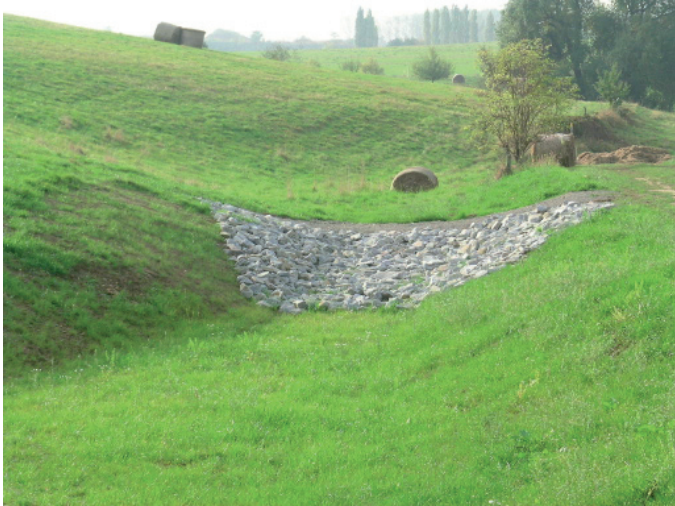
Nach der Hochwasserschadensbeseitigung: Furt aus Wasserbausteinen mit vertieftem Absetzbecken
