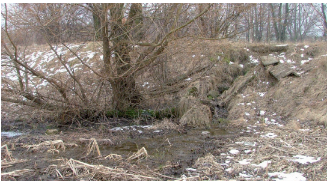
Vor der Hochwasserschadensbeseitigung: Überströmung des Auslaufbereichs des Kalkteichs und ausgespülter Damm
