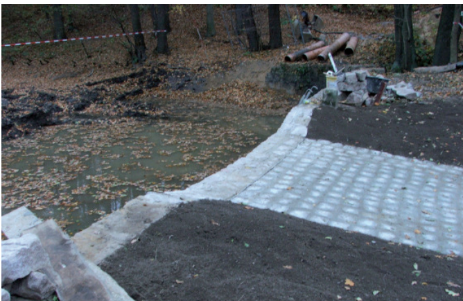
Nach der Hochwasserschadensbeseitigung: abgesenkte und instandgesetzte Ufermauer mit Überlaufrinne für den Hochwasserabfluss
