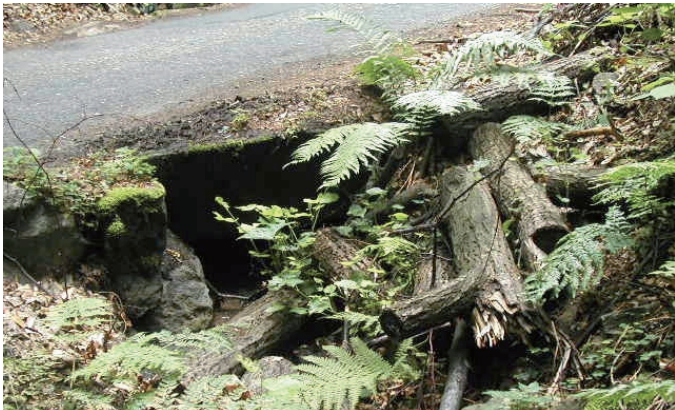
Vor der Hochwasserschadensbeseitigung: Straßenunterquerung, Geschiebe- und Totholzablagierungen
