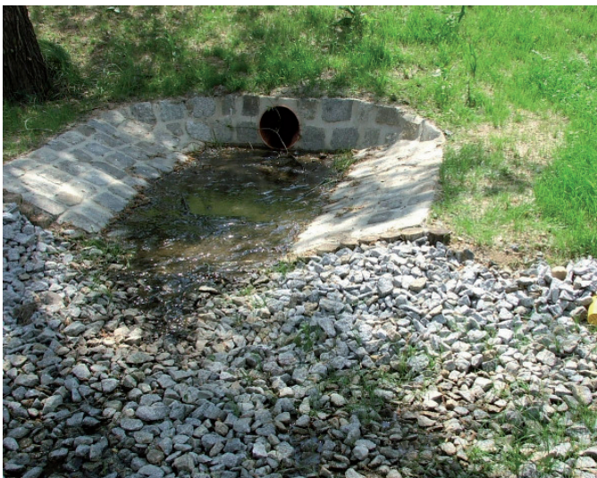
Nach der Hochwasserschadensbeseitigung: Wiederhergestellter Hochwasserentlastung
