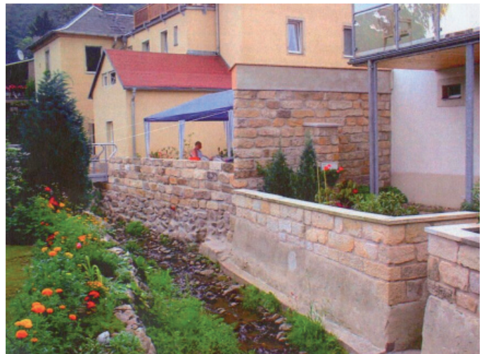
Nach der Hochwasserschadensbeseitigung: geräumtes Gewässerbett und wiederhergestellte Stützmauer
