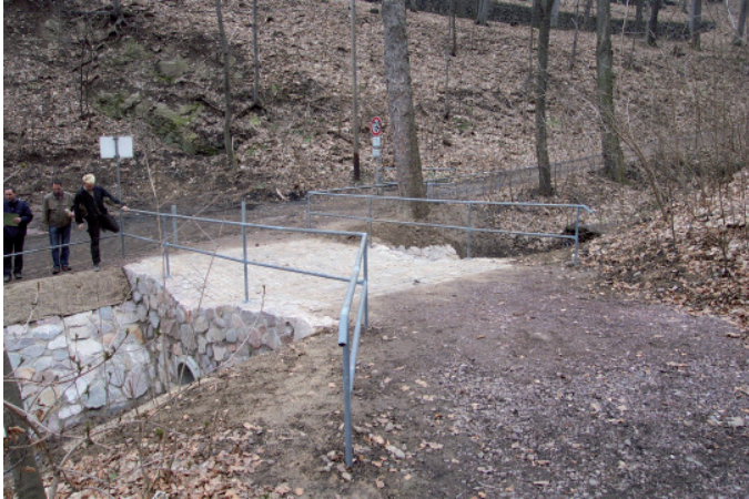
Nach der Hochwasserschadensbeseitigung: Auf dem Wegedamm eingebaute Überlaufmulde
