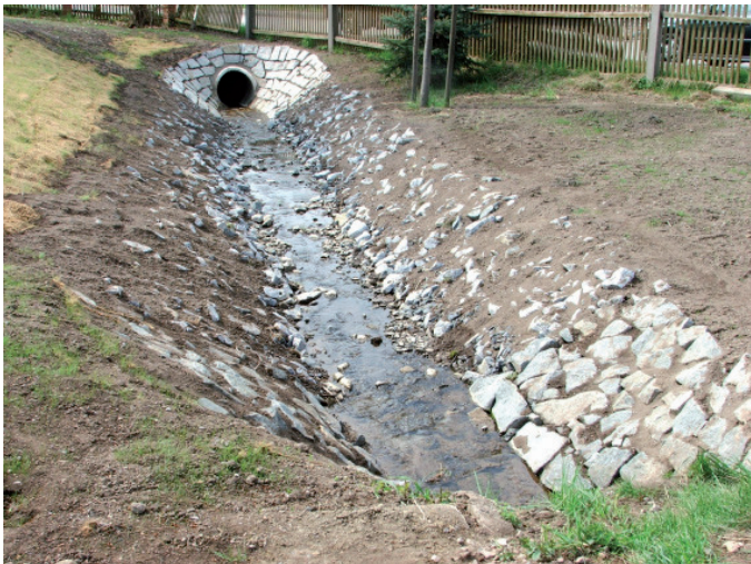
Nach der Hochwasserschadensbeseitigung: Neu eingebautes Rohr unter der Wegquerung und naturmah gesicherte Böschung
