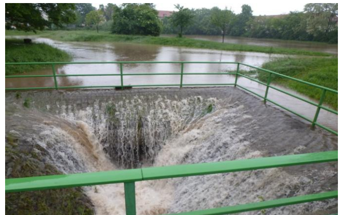
Hochwasserentlastung Hugo-Bürkner Park 03.06.2013 (Foto: Umweltamt)
