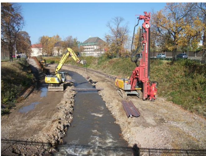
Abb.: Weißeritzausbau in Dresden Löbtau (Foto: Umweltamt 2012)
