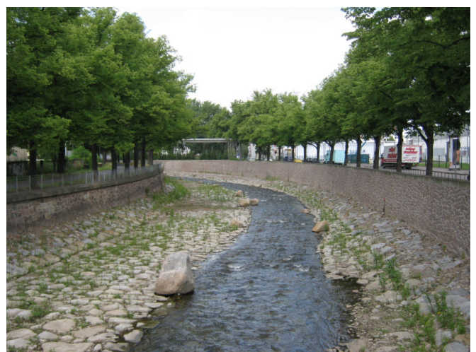
Foto: Neu ausgebaute Weißeritz in Dresden Plauen (Quelle: Umweltamt Landeshauptstadt Dresden 2012)
