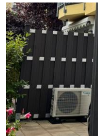
Ergänzung Erdgaskessel mit Klima-Splitgerät (Luft-Luft-Wärmepumpe)
