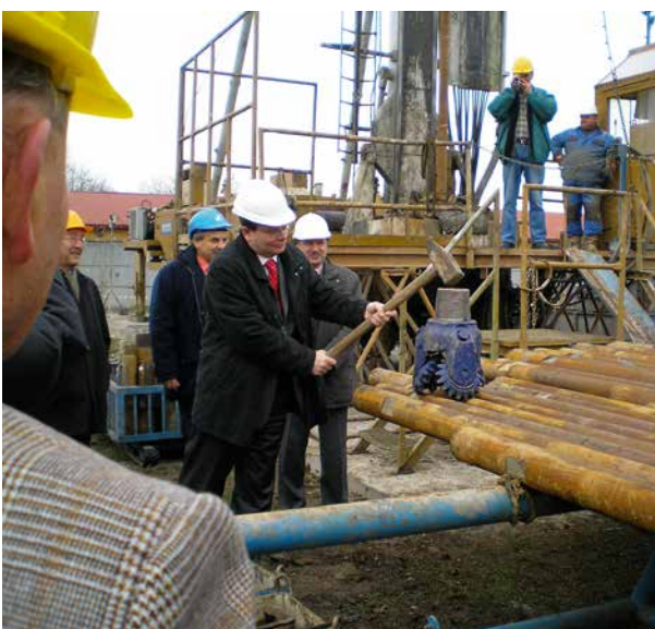
Start zkušebního vrtu / Start der Probebohrung
