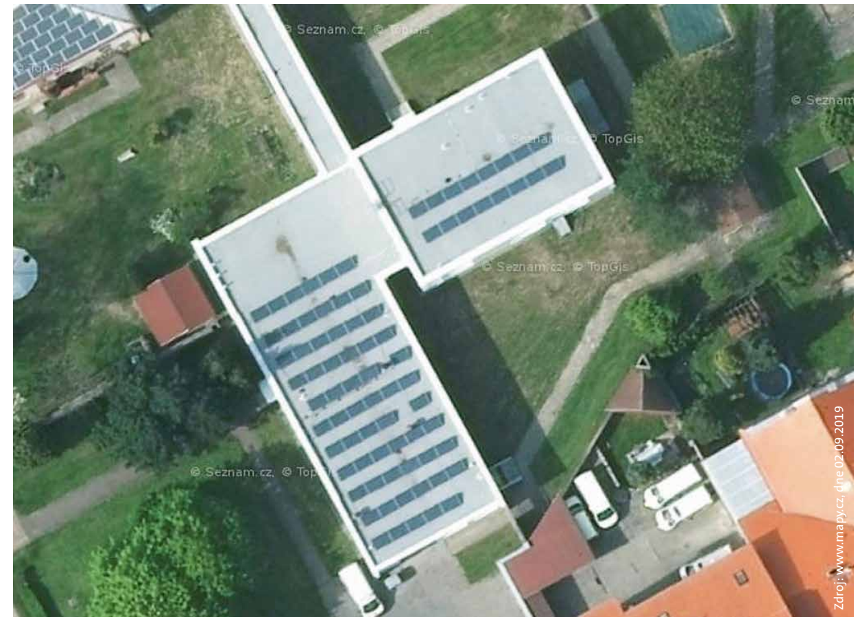
Obrázek 13 // Fotovoltaická elektrárna na budově MŠ Masarykova 590/30, Litoměřice
