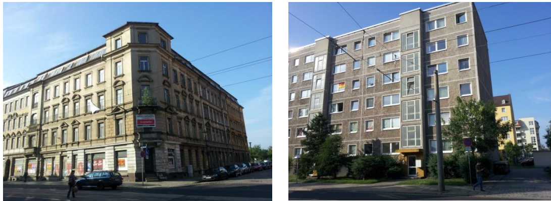
Abbildung 6–33: Ungenutzte Altbauten und elementierte Geschößwohnungsbauten
