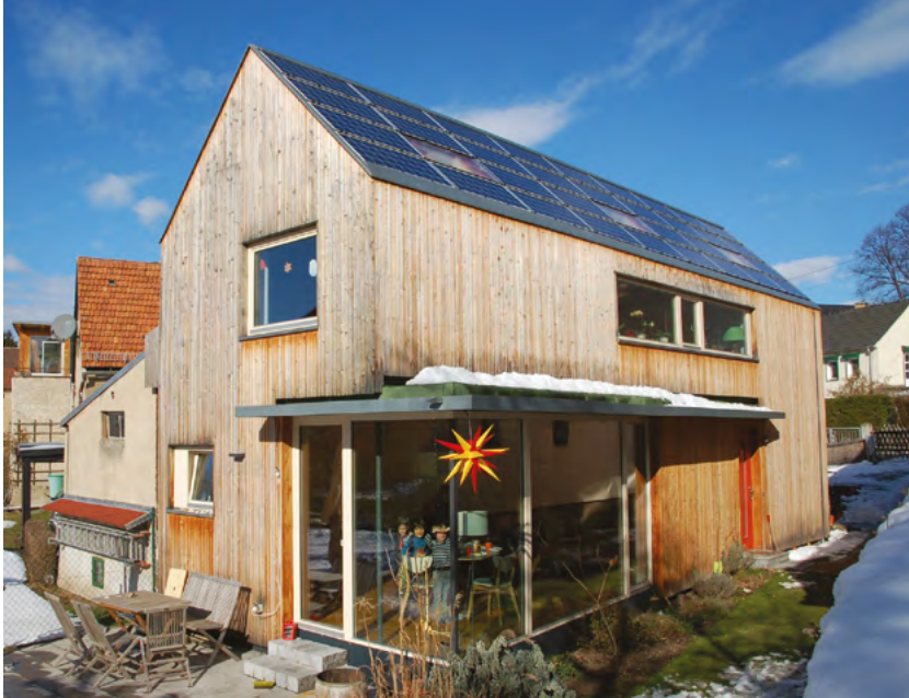
Abb. 2.3.4: Indach-Photovoltaikanlage auf kompletter Süddachfläche eines Wohnhauses in Dresden Hellerau, Architekt: Rentzsch Architekten (Foto: Olaf Reiter)
