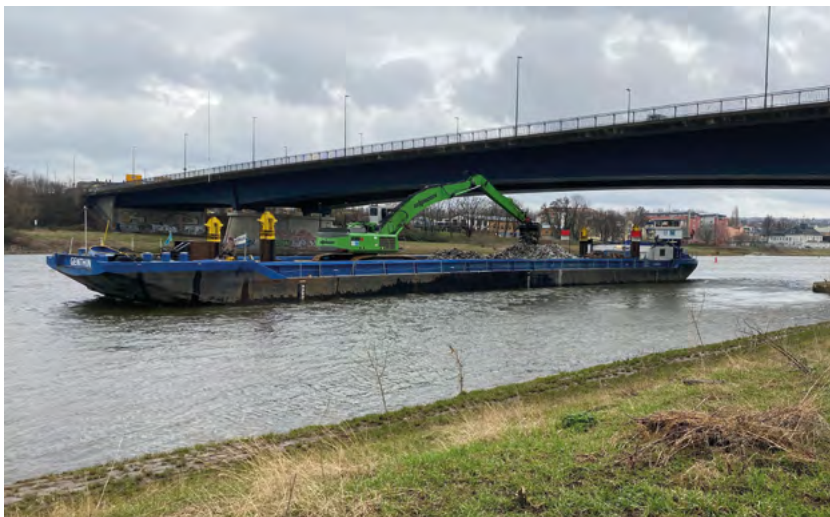
Abb. 5.6.3: Ein Spezialschiff versenkt Wasserbausteine auf dem Grund der Elbe. Sie sollen den sanierten Düker vor Schäden durch Schiffsanker schützen (Foto: Torsten Fiedler).
