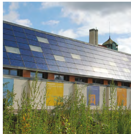
Abb. 2.3.5: Indach-Photovoltaikanlage auf dem Süddach des Bürogebäudes GebäudeEnsemble Deutsche Werkstätten Hellerau, Architekt: Prof. Morgenstern, (Foto: Olaf Reiter)
