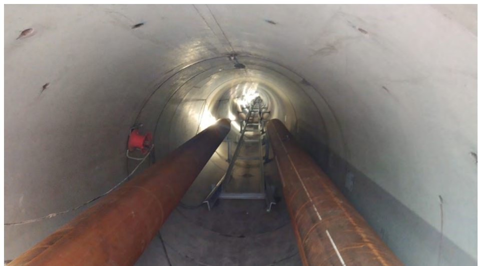
Abb. 2.3.1 u. 2.3.2 : Elbdüker zur Versorgung des Gebietes nördlich der Elbe mit Fernwärme (Fotos: Landeshauptstadt Dresden, Klimaschutzstab)
