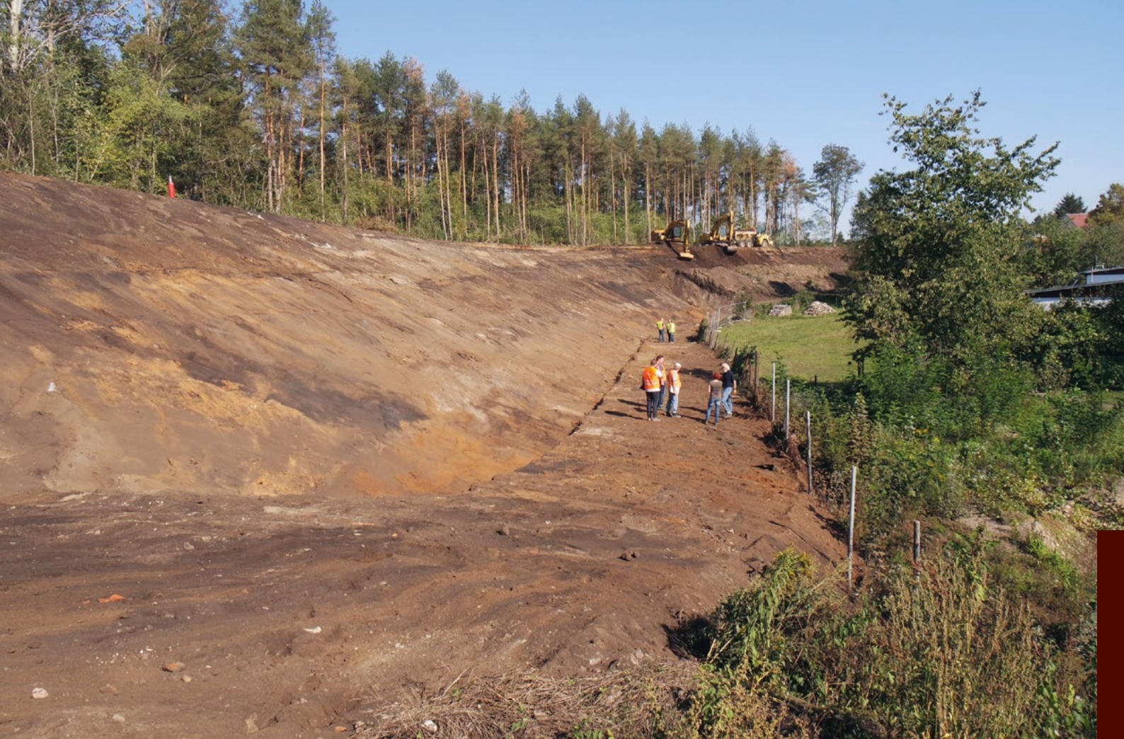
Abb. 5.7.4: Probesanierung Collmberghalde – Abtrag (Foto: Umweltamt)
