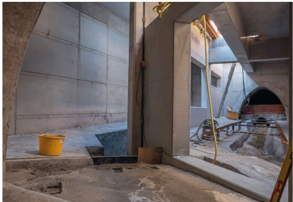
Abb. 6.5.5: Das unterirdische Entlastungsbauwerk am Rathenauplatz wird modernisiert und zusätzlicher Stauraum geschaffen, um die Elbe zu schützen (Foto: SEDD)
