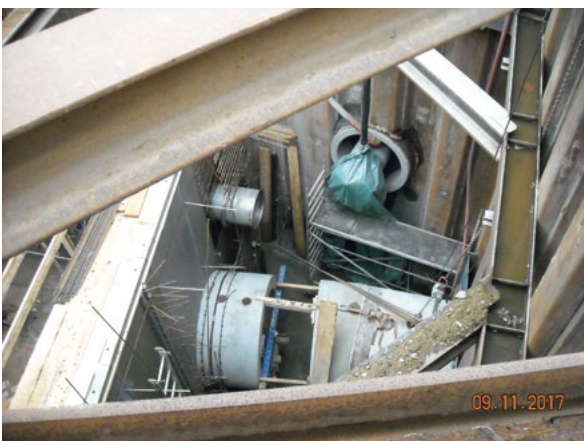
Abb. 6.2.22: Pumpwerk, Zulaufleitung DN 1500 aus Richtung Regenüberlaufbauwerk Prießnitzstraße, Druckleitungsabgang (Folie) (Foto: Umweltamt)
