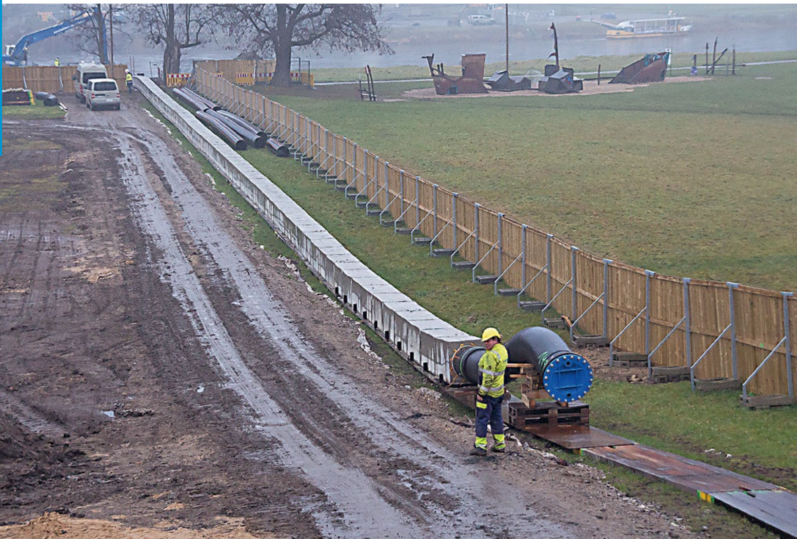
Abb. 6.5.2: Elbquerung (Düker) zum Altstädter Abfangkanal (Foto: SEDD)
