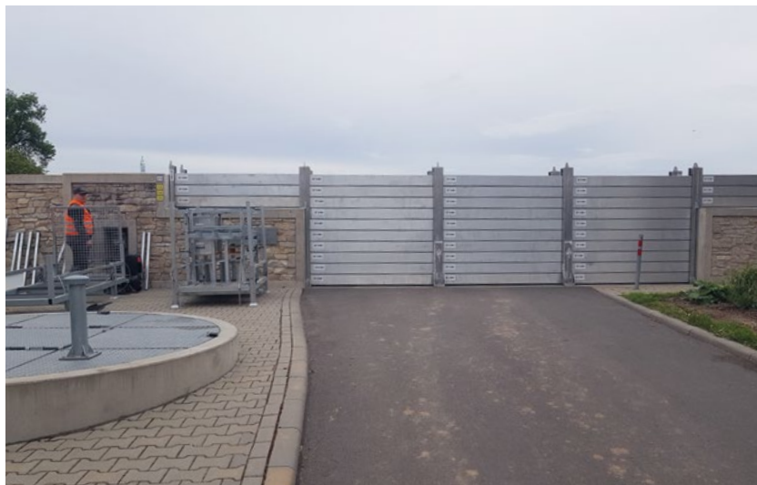
Abb. 6.6.2: Hochwasserschutzwand mit mobilen Elementen östlich der Ortslage Gohlis (Foto: Umweltamt)
