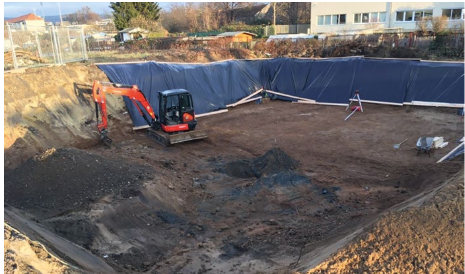
Abb. 5.7.2: Sanierungsbaustelle auf der Gasanstaltstraße, Bodensanierung mittels klassischem Bodenaustausch und Neubau eines Gewerbegebäudes (Foto: Umweltamt)
