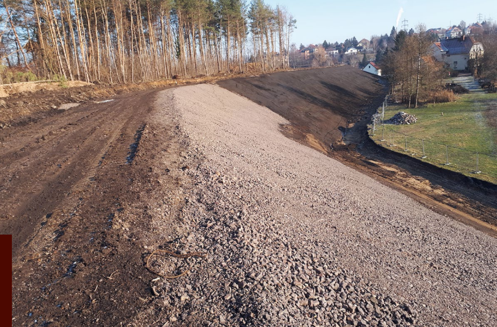
Abb. 5.7.6: Probesanierung hergestellte Radonsperre (Foto: Umweltamt)
