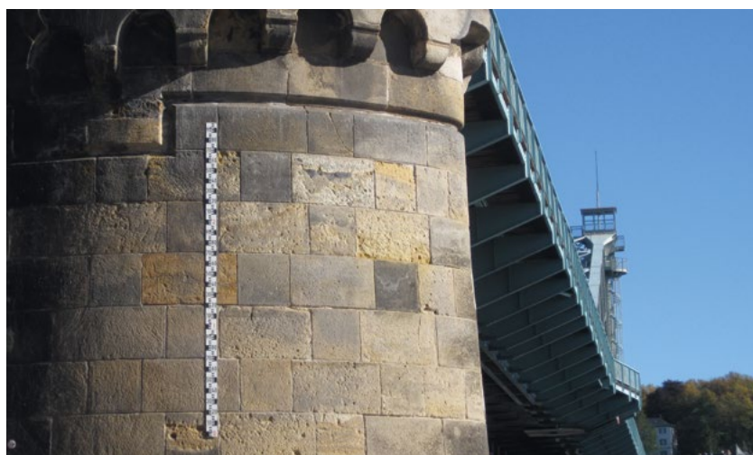
Abb. 6.6.5: Messlatte am Blauen Wunder (links), Messlattenmarkierung am Fährgarten Johannstadt (rechts) (Abbildung: Umweltamt)
