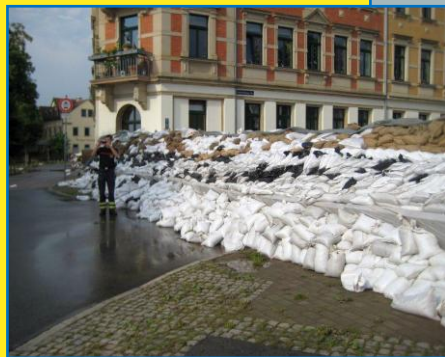
Sandsackverbau Scharfen- berger Str./Böcklinstr., Elbe-Hochwasser Juni 2013
