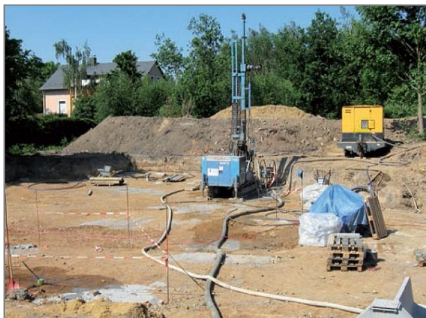
Abb. 5.3.9: Bohrung für eine Erdwärmesonde (©: Umweltamt)
