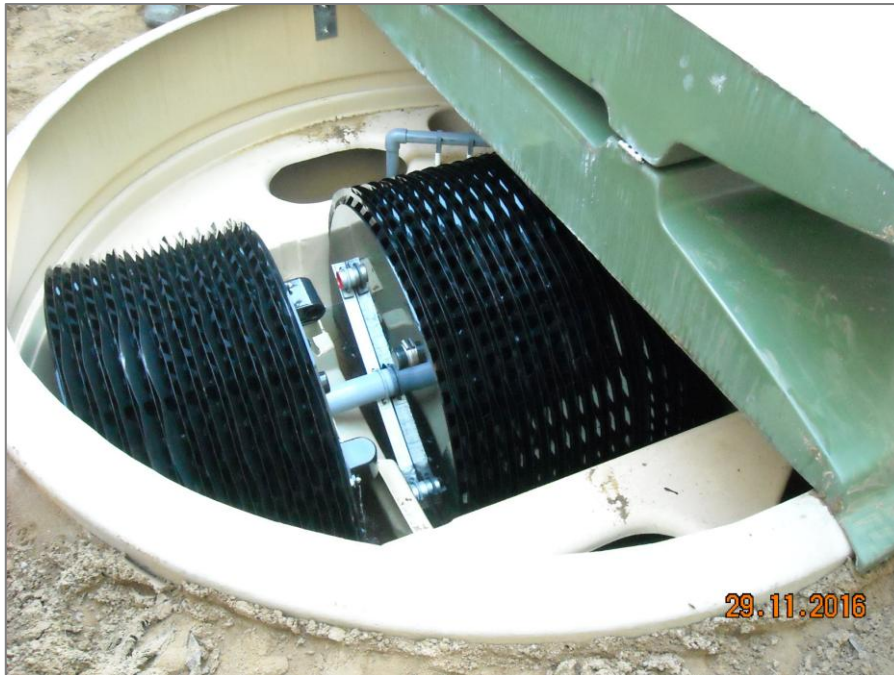
Abb. 5.2.12: Neu eingebaute Scheibentauchkörperanlage (Kleinkläranlage) (©: Umweltamt)
