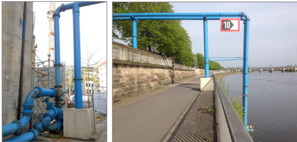
Abb. 5.3.7 und Abb. 5.3.8: Anschlussrohre einer Grundwasserhaltung und Ableitung in die Elbe (©: Umweltamt)
