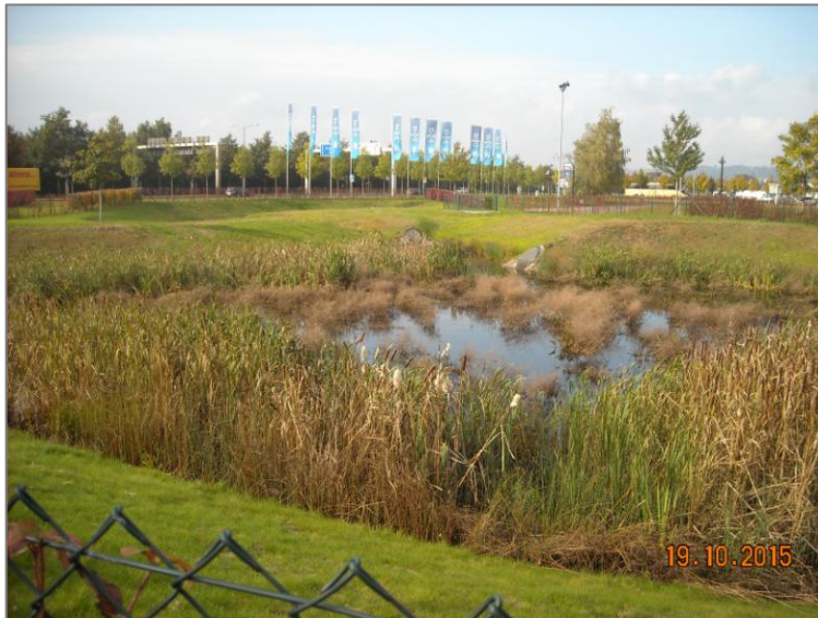
Abb. 5.2.13: Regenrückhaltebecken Einkaufszentrum Elbepark, Dresden-Kaditz/Mickten (©: Umweltamt)
