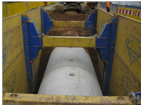
Abb. 5.5.1: Neubau Altstädter Abfangkanal in offener Bauweise (©: SEDD GmbH)
