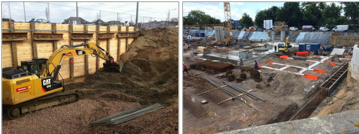
Abb. 4.6.2: Sanierungsbaustelle auf der Schandauer Straße, Bodensanierung mittels klassischem Bodenaustausch und Neubau von Wohngebäuden (©: Umweltamt)
