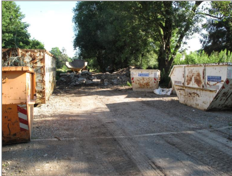
Abb. 3.4.6: Baufortschritt während des Abrisses; Sammlung und Sortierung des Abbruchmaterials, Juli 2016 (©: Umweltamt)
