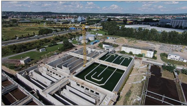
Abb. 5.5.3: Dichtheitsprüfung der neuen Becken im August 2016 (©: SEDD GmbH)
