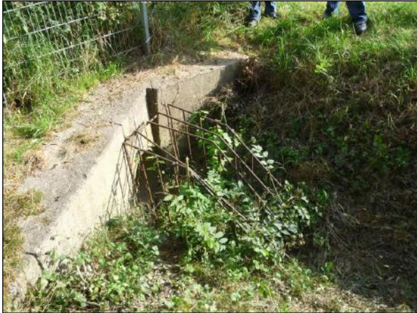
Bild 1: Vor Beginn der Maßnahme: Einlauf in die Verrohrung
