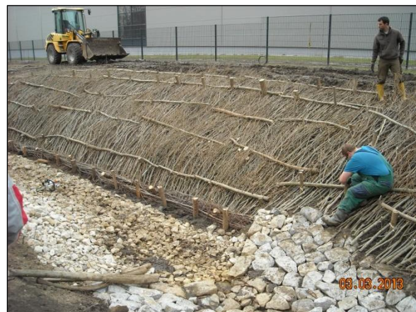
Bild 5: Herstellung Spreitlage
