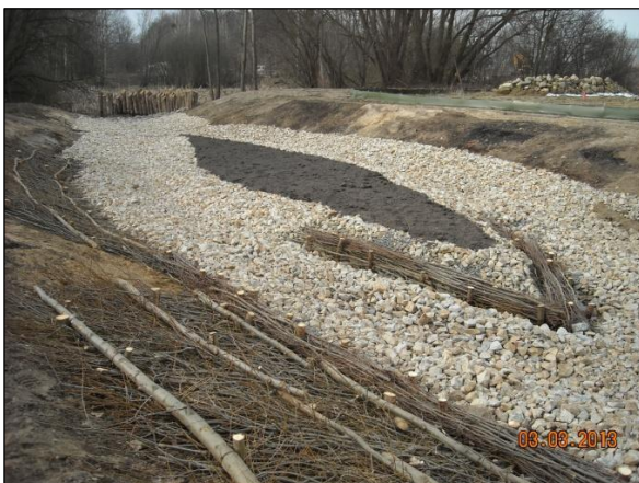
Bild 4: Insel kurz vor Baufertigstellung mit Bauwasserhaltung (April 2013)
