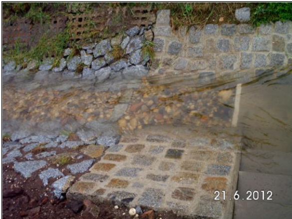
Bild 6: Während dem Bau: Detail Messgerinne, 21.06.2012
