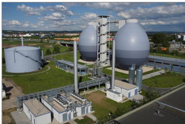
2012: vorn das BHKW, hinten links Gasspeicher, mittig Anlagen zur Gasaufbereitung, hinten rechts: Faultürme und Maschinenhalle mit Schlammaufbereitung
