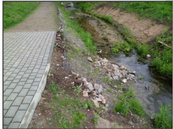
Bild 9: Beispiel für ingenieurblogische Bauweisen BF 1.1 - begrünte Drahtschotterkörper stabilisieren Weg und Böschung, Mai 2012
