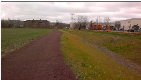
Bild 8: fertiggestellter, neuprofilierter Maltengraben oberstrom Durchlass Am Lugaer Graben
