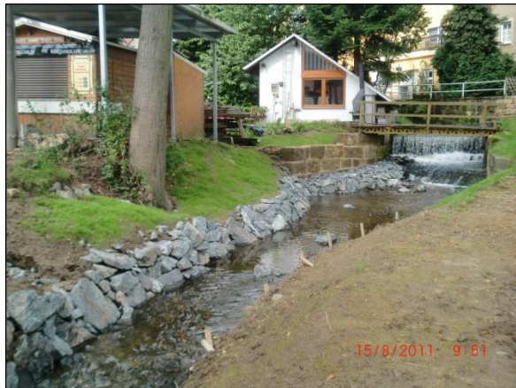
Bild 5: Nach der Maßnahme: instandgesetzte Mauer und abgeflachte Böschung
