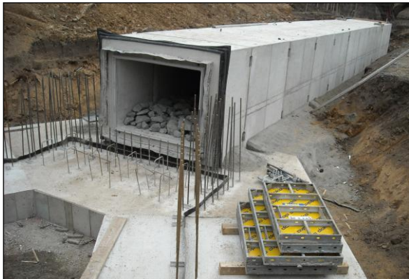
Bild 4: Während der Maßnahme: Drosseldurchlass vor Aufschüttung des Hauptdammes: Vorn die Fundamente für das Einlassbauwerk; in den Betonfertigteilen wird die raue Gewässersohle durch Grobschotter erzielt
