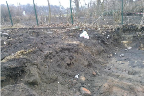
Abbildung 4: Bodenaustausch in kontaminierten Altlastenflächen
