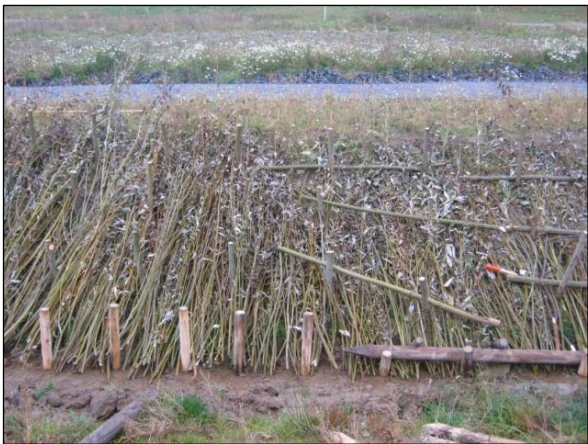
Bild 7: Während Bau: Ing.biologische Sicherung der Böschungen, 25.10.2012
