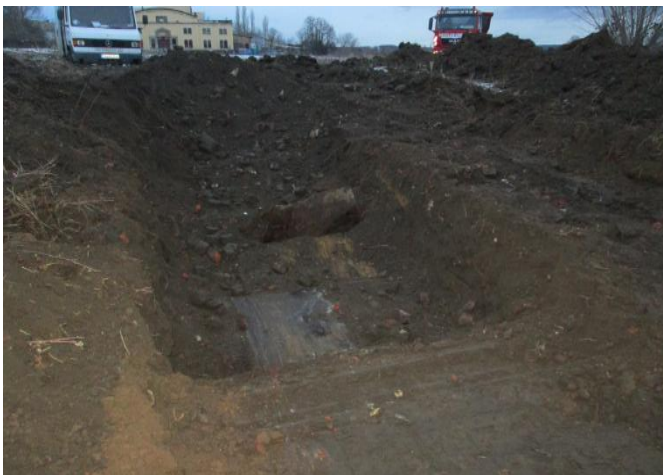
Abbildung 3: Schürfen in Vorbereitung der Entsorgung des kontaminierten Erdaushubes
