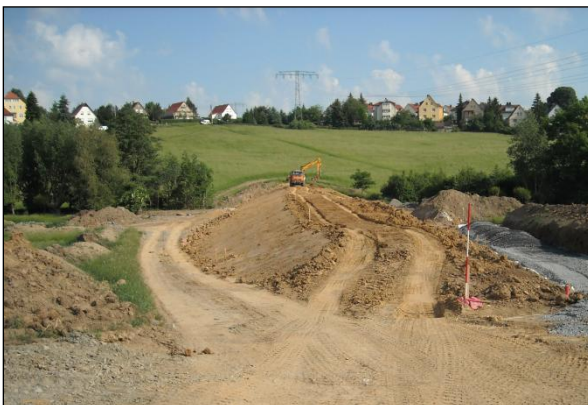
Bild 5: Während der Maßnahme: Aufschüttung und Verdichtung des Dammkörpers
