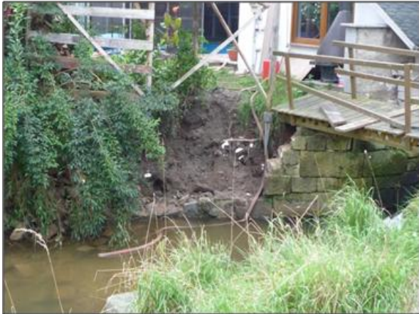
Bild 2: Vor Beginn der Maßnahme: zerstörte Ufermauer
