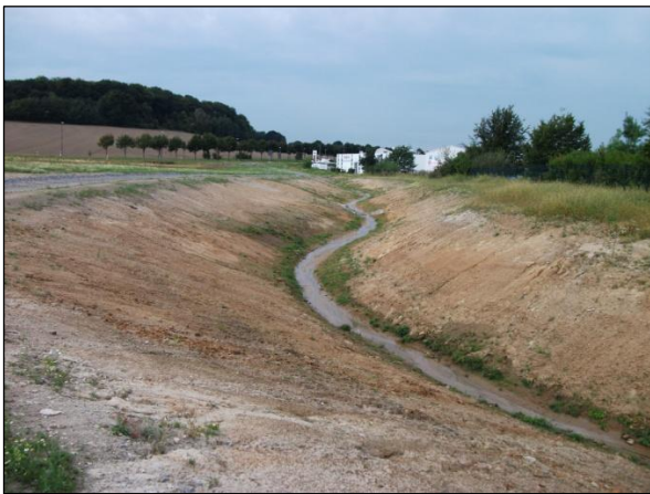
Bild 6: Während Bau: neuprofilierter Kirchweggraben, 31.08.2012
