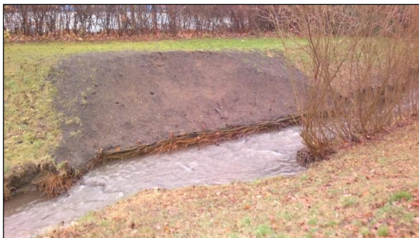
Bild 3: Uferabbruch vor der Reparatur; Blick stromauf
