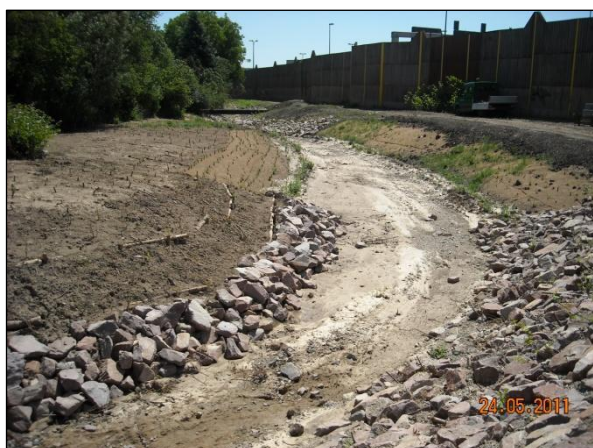
Bild 9: Kurz vor Fertigstellung: aufgeweiteter Weidigtbach mit ingenieurbioologischer Böschungssicherung
