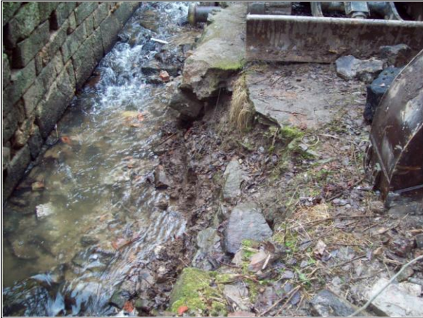
Bild 3: Vor Beginn der Maßnahme: zerstörte Uferbefestigung
