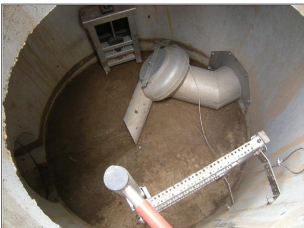
Bild 8: Während VOB-Abnahme: Blick in Drosselschacht HWRB 1
