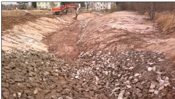
Bild 5: während Bau: Neuprofilierung des Maltengraben
