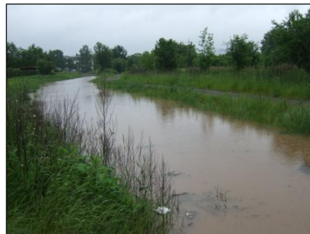
Bild 11: neuprofilierter Maltengraben im Bereich Am Lugaer Graben beim Hochwasser im Juni 2013, der hohe Wasserstand wurde durch Einstau vom Lockwitzbach verursacht, 03.06.2013
