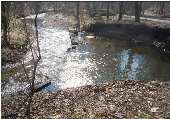
Bild 1: Auskolkung (etwa 14 x 8 m) vor Maßnahmebeginn; Blick stromab
