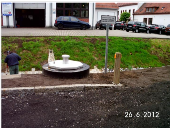
Bild 8: Während dem Bau: Messstelle mit Messschacht, gesichert mit Überfahrtschutz (Kantstein), Poller und Hinweisschild, 26.06.2012
