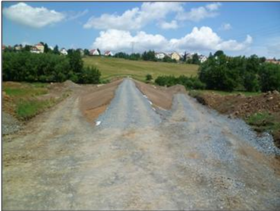
Bild 7: Damm Hochwasserrückhaltebecken Kaitzbach kurz vor der Fertigstellung, Juni 2012
