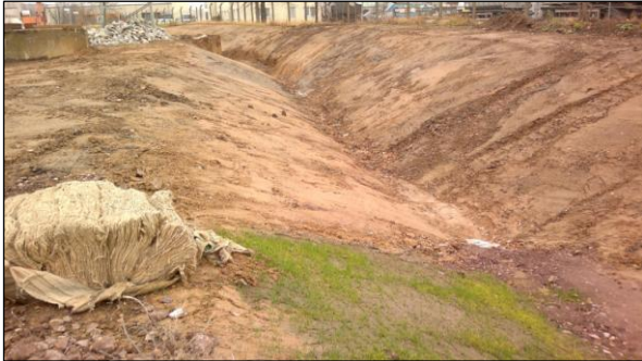
Bild 7: während Bau: Böschungssicherung am neuprofilierten Maltengraben
