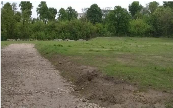
Abbildung 5: grundhafter Wegeausbau mit RC-Material im Bereich der zukünftigen Parkerschließung, Oberbodenandeckung und Rasenansaat
