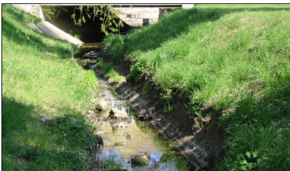
Bild 2: Vor der Maßnahme: Vorhandene Rasengitterplatten
