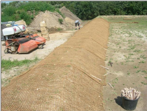
Bild 6: Während des Baues: Verlegung Kokosmatten auf Damm HWRB 3
