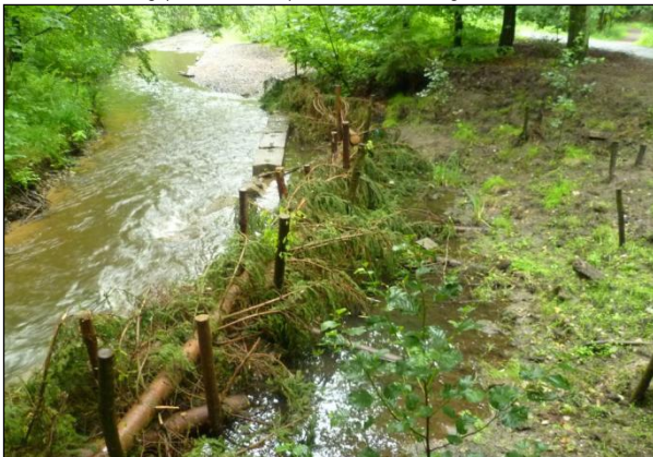
Bild 2: Rauhbaumverbau, Hinterfüllung und Bepflanzung; Blick stromab
