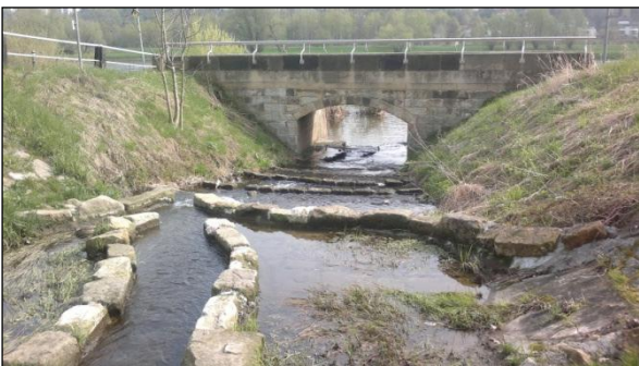
Bild 4: Kaskadentreppe nach Fertigstellung
