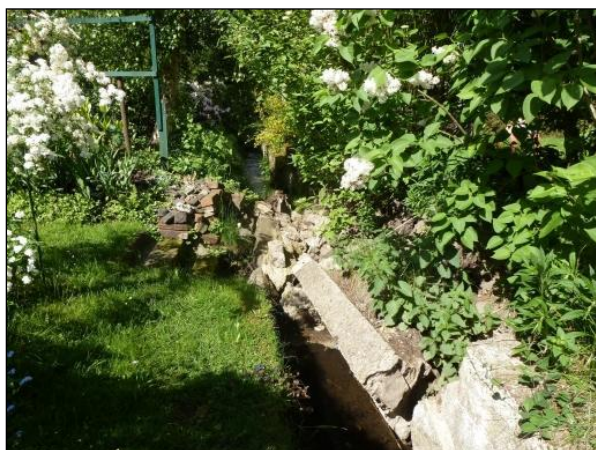
Bild 2: Vor der Maßnahme: In Abflussprofil gebrochene Ufermauerteile (2013)
