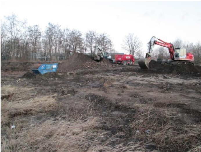
Abbildung 5: Laden und Transport von kontaminiertem Bauschutt / Erdaushub
