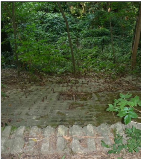
Bild 2: Vor Beginn der Maßnahme. Hangsicherung Rasengitterplatten
