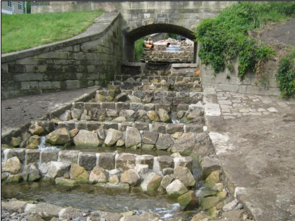
Bild 3: Kaskadentreppe kurz vor Fertigstellung
