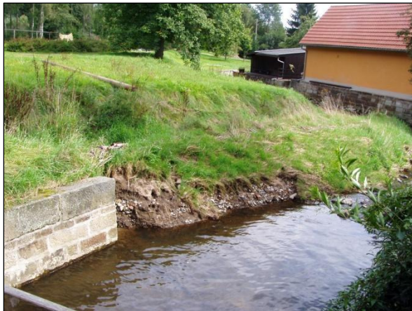
Bild 3: Vor Beginn der Maßnahme: ausgespülte Böschung unterstrom Mauer
