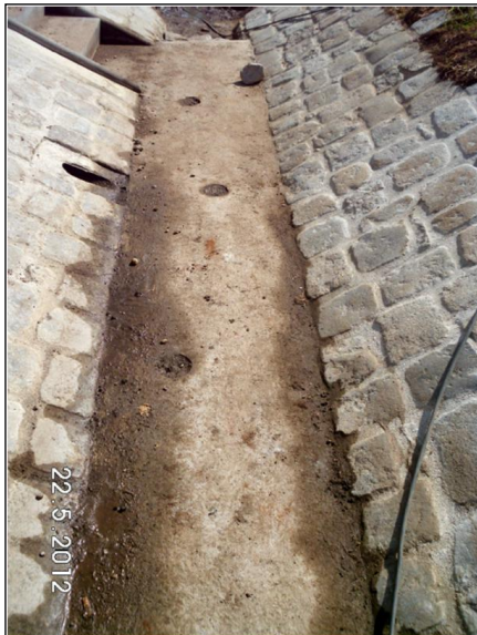
Bild 4: Während dem Bau: Sohlplatte im Bereich der Messstrecke, 22.05.2012
