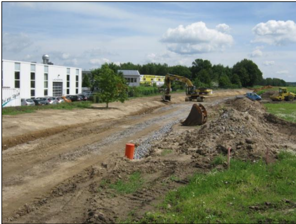
Bild 5: Während Bau: Profilierung des Gewässers, 07.06.2012
