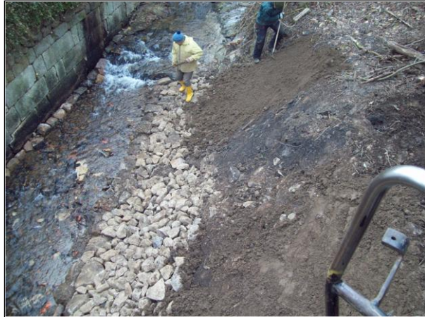
Bild 6: Während der Maßnahme: Herstellung/Befestigung linke Uferböschung
