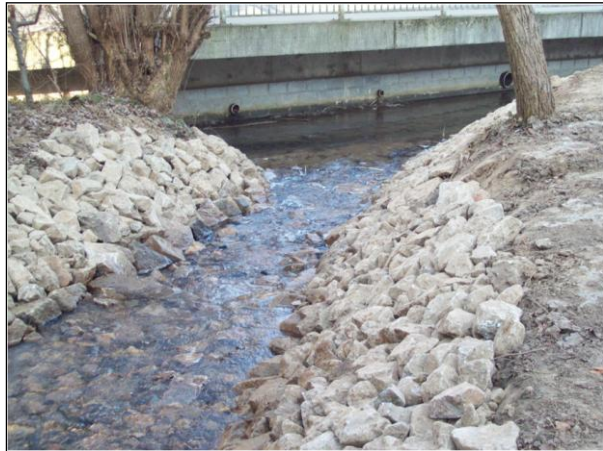
Bild 7: Kurz vor Abschluss der Maßnahme: befestigter Mündungsbereich
