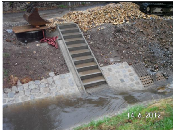
Bild 5: Während dem Bau: Messstelle mit Schacht und Pegeltreppe, 14.06.2012
