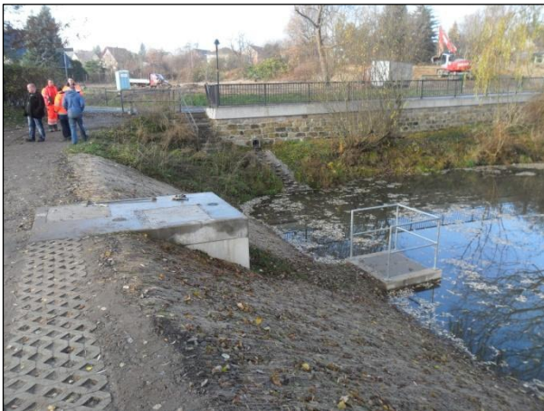
Bild 5: Damm und Auslaufbauwerk des Rochwitzer Dorfteiches nach der Fertigstellung
