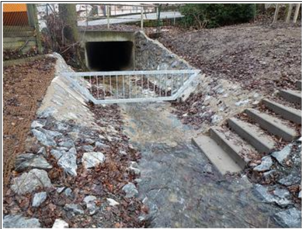
Bild 3: Treibgutfang kurz nach Fertigstellung der Ertüchtigung
