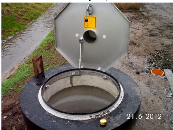
Bild 7: Während dem Bau: Detail Messschacht, 21.06.2012
