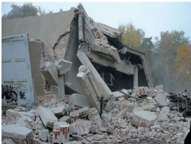
Abb. 6.3.3: Sprengung Ikarusweg: In Gebieten, die nicht schallsensibel sind, ist die Palette der einsetzbaren Technologien wesentlich breiter.
