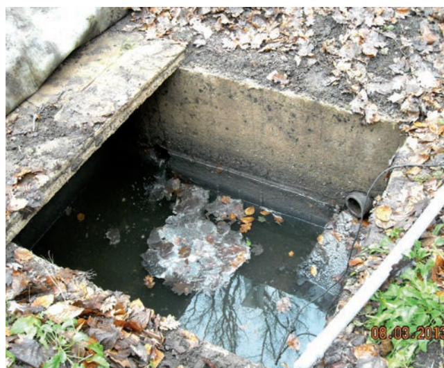
Abb. 5.2.13: Sanierungsbedürftige Abwassergrube
