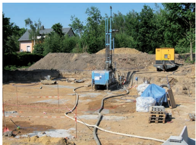
Abb. 5.3.9: Bohrung für eine Erdwärmesonde
