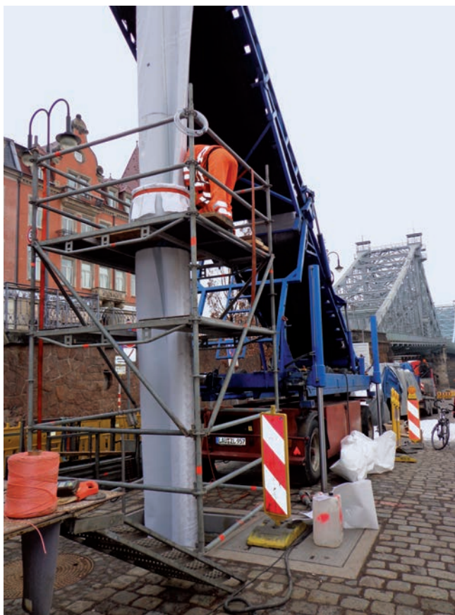
Abb. 6.3.4: Kanalsanierung Schillerplatz 2011 im Insitutformverfahren: In komplizierten Innenstadtlagen kann die klassische aufwändige und langwierige offene Bauweise vermieden werden. Aber auch hier ist eine schalltechnische Begleitung erforderlich.
