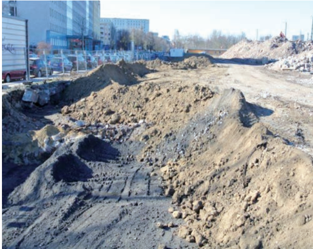
Abb. 4.5.5: Tiefenenttrümmerung, Rückverfüllung nach Ausbau der Gründerzeit-Keller an der Strehlemer Straße
