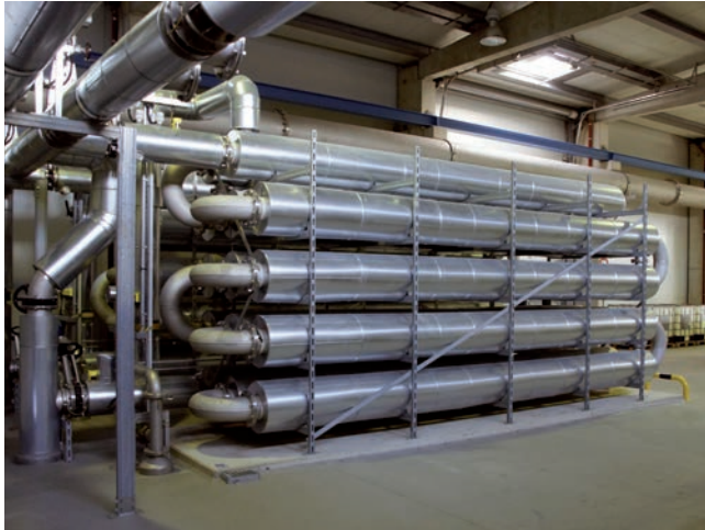
Abb. 5.2.5: Wärmetauscher der neuen Schlammbehandlungsanlage
