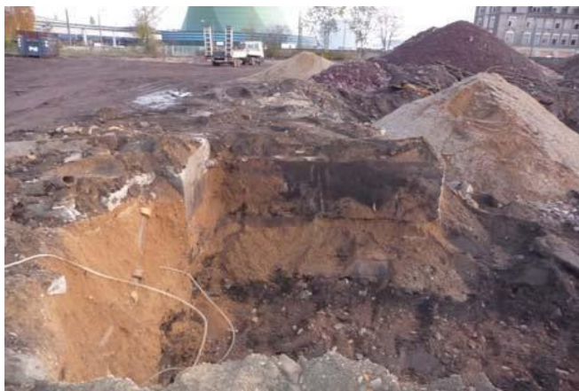
Bild 2: Zustand während der Tiefenentrümmerung
