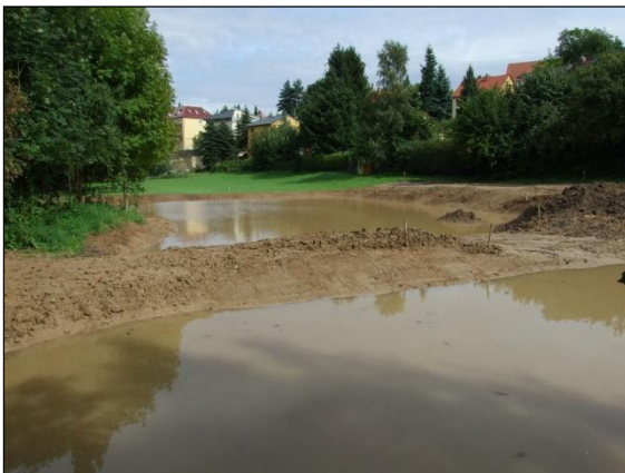
Bild 5: Während der Maßnahme: Flutmulden vor Bepflanzung
