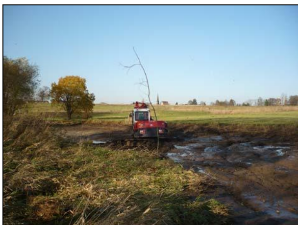
Bild 3: Aushub des verlandeten Teiches
