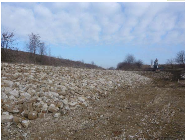
Abbildung 6: Böschungsverbau
