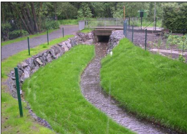
Bild 5: Neugestaltetes Gerinne nach der 1. Vegetationsperiode
