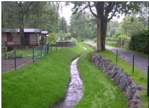
Bild 6: Neugestaltetes Gerinne nach der 1. Vegetationsperiode
