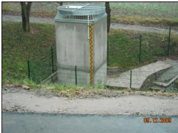
Bild 6: nach dem Bau: Schachtüberfall
