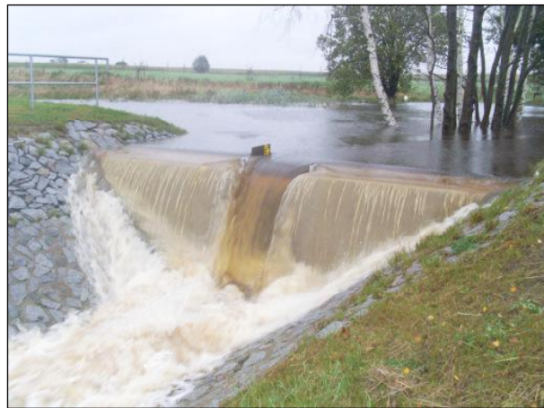
Bild 6: Hochwasserabfluss am 27./28.09.2010, Hochwasserentlastung angesprungen
