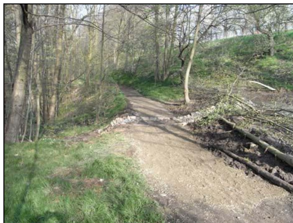
Bild 6: gesicherter Hangwasseraustrittsbereich und Wegeüberlauf
