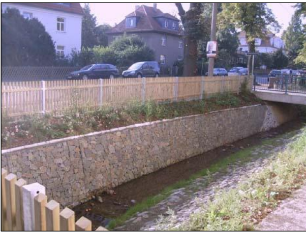
Bild 5: Nach der Maßnahme: offengelegter Bachverlauf mit Gabionenwand
