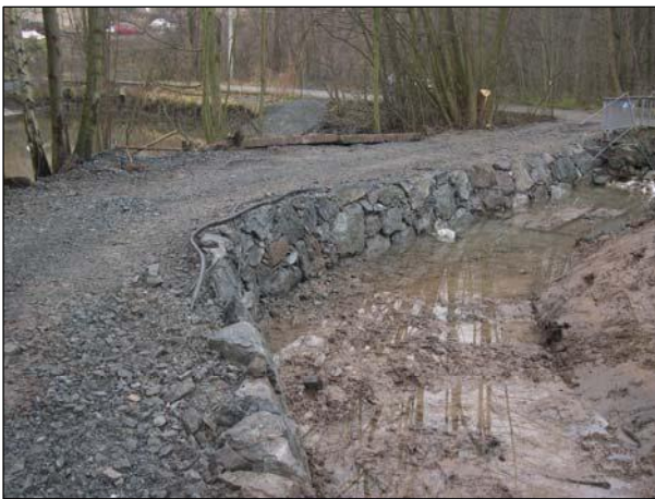
Bild 4: Während des Maßnahme: aufgeweitetes Gerinne
