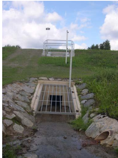
Bild 6: nach der Baumaßnahme: HWRB Weißiger Dorfbach, Ablaufbauwerk und Hochwasserentlastung
