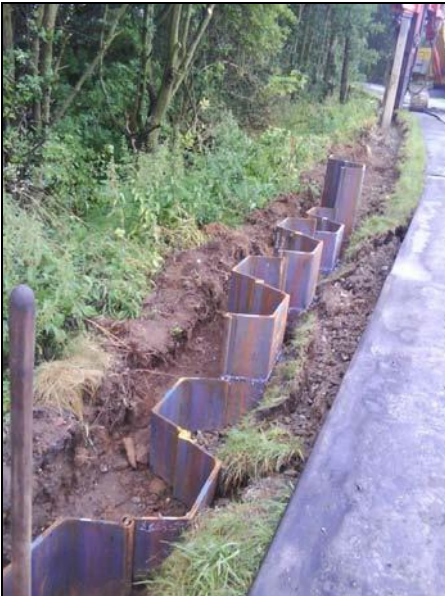
Bild 4: Einbringen der Dichtungswand
