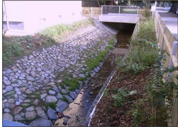
Bild 4: Nach der Maßnahme: offengelegter Bachverlauf mit abgeflachter Böschung
