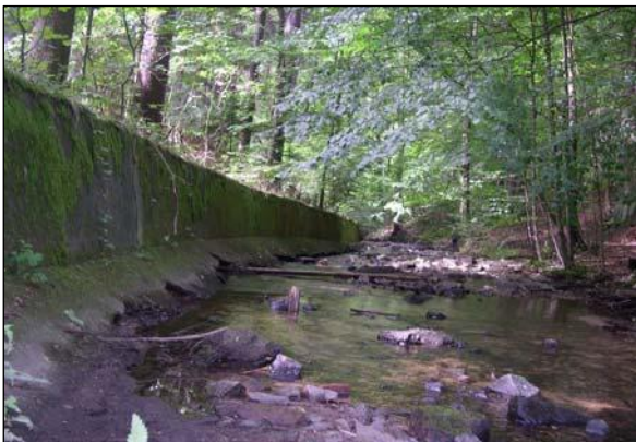
Bild 2: Vor der Maßnahme: Uferbefestigung mit Betonmauer
