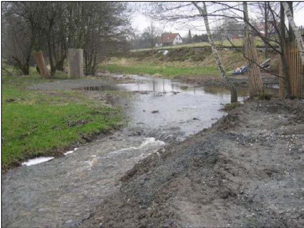
Bild 3: Während der Baumaßnahme: zukünftige Rückhaltefläche für Speicher
