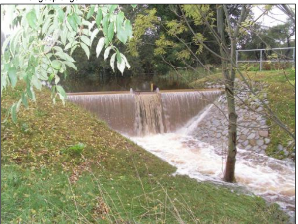
Bild 7: Hochwasserabfluss am 27./28.09.2010, Hochwasserentlastung angesprungen
