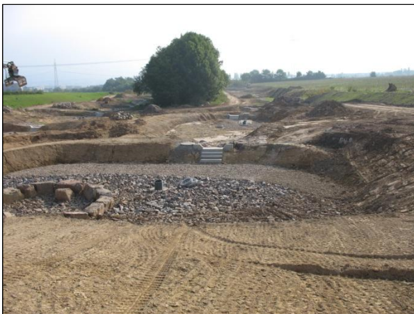
Bild 4: Während der Maßnahme: Flutmulden
