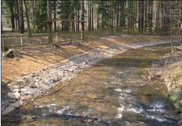
Bild 3: Nach der Maßnahme: hergestellte neue Uferböschung mit „lebenden Steinsatz“
