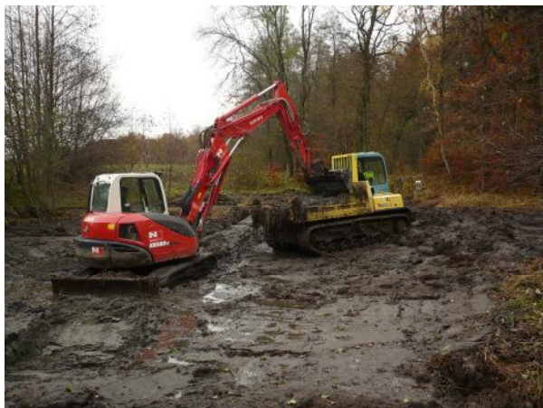
Bild 3: Aushub des verlandeten Teiches
