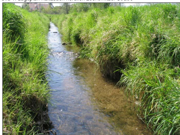
Bild 2: gestreckter, unter Bewuchs ausgebauter, tlw. bereits ausgespülter Gewässerabschnitt; Blick stromauf
