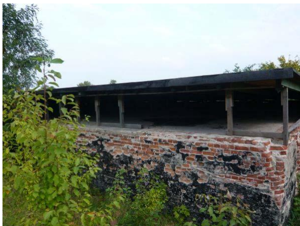
Abbildung 3: Hinteransicht mit Notdachkonstruktion
