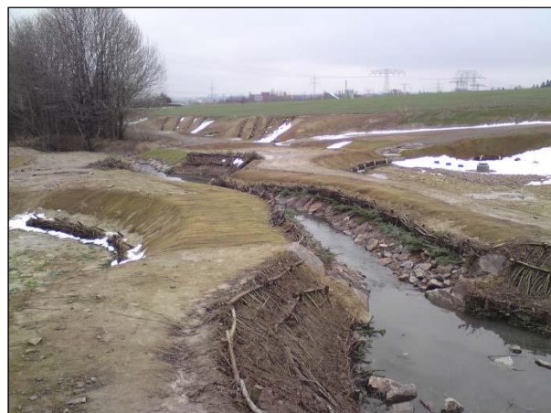
Bild 7: Nach der Maßnahme: Details der ingenieurbologischen Sicherungsmaßnahmen am Weidigtbach
