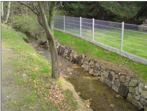
Bild 4: Nach der Maßnahme: instandgesetzte Ufermauer
