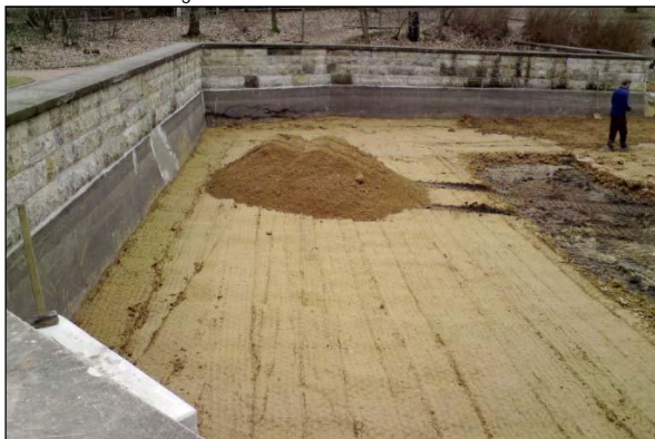
Bild 5: Aufbau der neuen, gedichteten Sohlschürze; Blick stromquer
