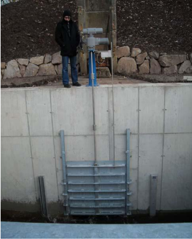
Bild 3: Nach der Maßnahme zur Hochwasservorsorge: Neugebaute Hochwasserentlastung
