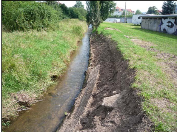
Bild 3: Rückbau der Uferbefestigung und Uferabflachung; Blick stromab
