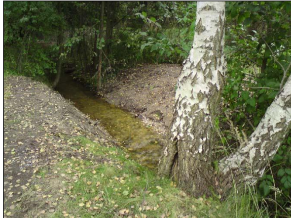
Bild 5: Nach der Maßnahme: rückgebauter Durchlass
