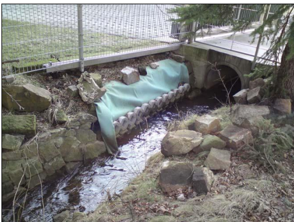
Bild 2: Vor der Maßnahme: Sanierungsbedarf im Böschungsbereich
