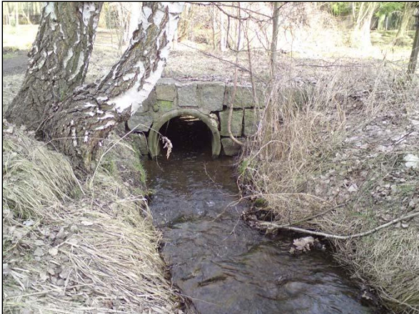
Bild 3: Vor der Maßnahme: zu kleiner Durchlass an ungenutzter Überfahrt
