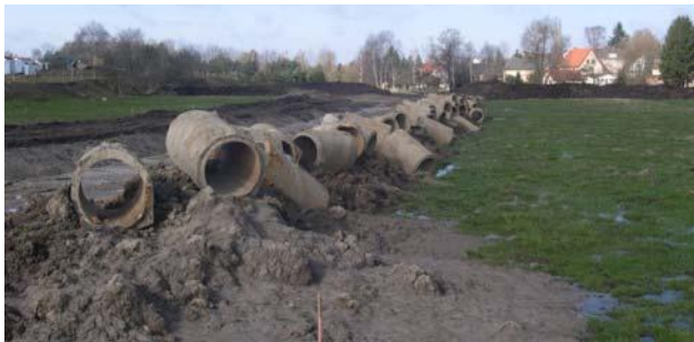
Bild 4: während der Baumaßnahme: Offenlegung Weißiger Dorfbach
