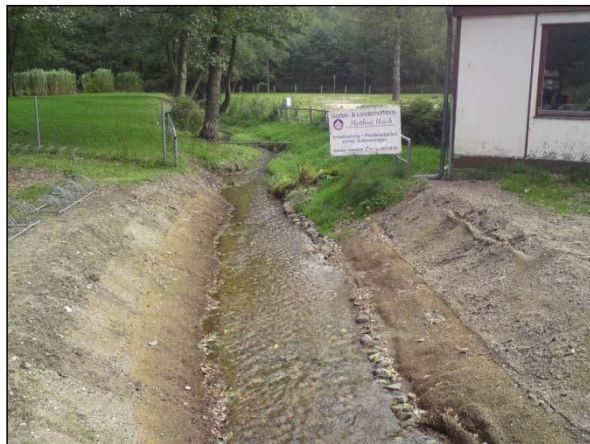
Bild 6: Nach der Maßnahme: verbreitertes Abflussprofil
