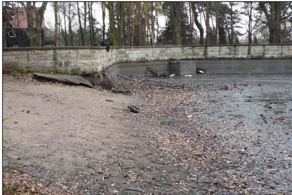
Bild 3: Teich nach Wasserabsenkung und Abfischung, tlw. schadhafte Ufermauern und Ablassbauwerke; Blick stromab
