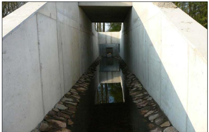
Bild 5: Durchlassbauwerk des HWRB Bartlake („Ökoschlucht“)
