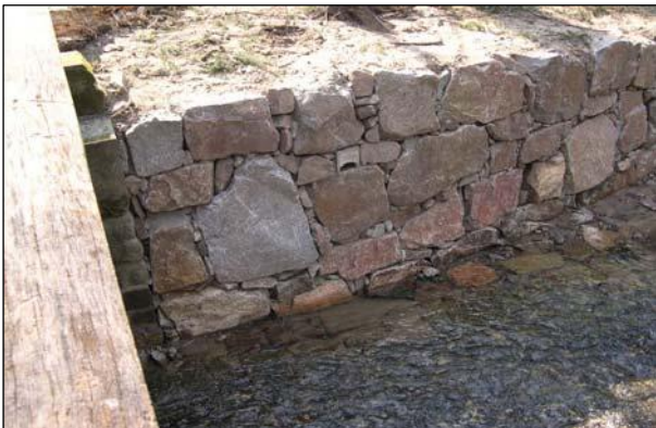
Bild 4: Nach der Maßnahme: hergestelltes Widerlager am Brückenbauwerk (Trockenmauer)
