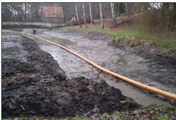
Bild 4: Wasserhaltung und Sammelrinne für Sediment; Blick stromauf
