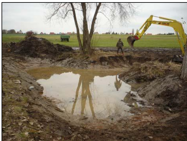
Bild 3: Aushub des Verlandungsbereiches und Grabenzulaufes
