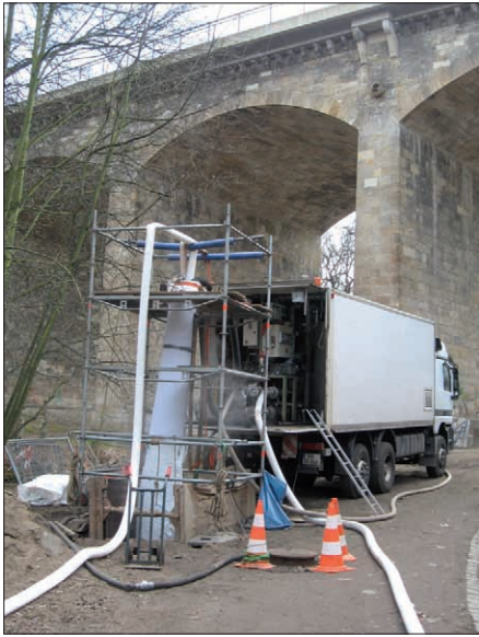
Abb. 5.5.2: Bauarbeiten während der Sanierung von zwei Abwasserkanälen im Prießnitzgrund - Einziehen des kunstharzgetränkten Filzschlauches
