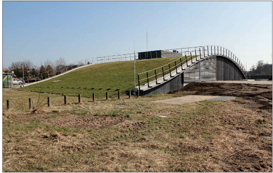
Abb. 5.5.3: Das Einstiegs- und Belüftungsgebäude des Hochwasserpumpwerkes Johannstadt wurde behutsam in die geschützten Elbwiesen eingebettet. Die Elbseite erhielt ein Gründach.
