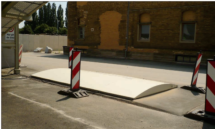
Abb. 5.7.1: Abfüllplatz einer Eigenverbrauchstankstelle im Überschwemmungsgebiet
