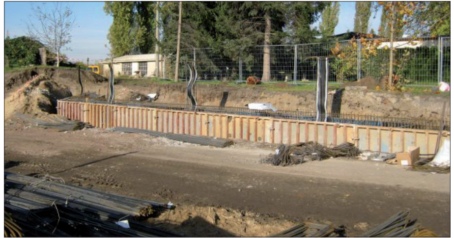
Abb. 5.6.3: Bau der Hochwasserschutzanlage entlang der Kötzschenbroder Straße, Oktober 2010
