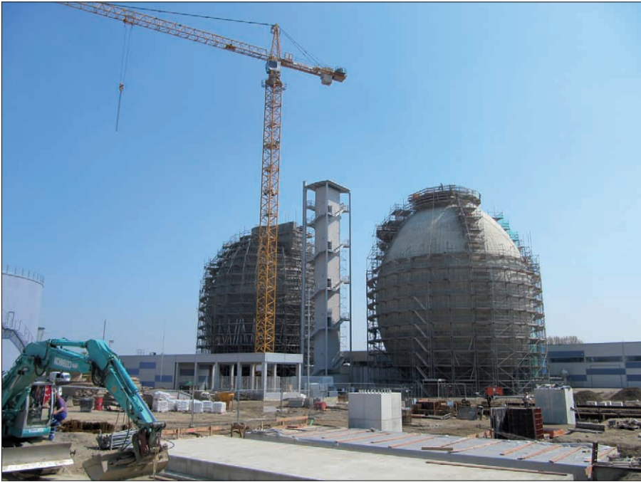
Abb 5.5.4: Bau von zwei 35 Meter hohen Faultürmen an der Autobahn A 4. Die Inbetriebnahme des ersten Behälters ist für das vierte Quartal 2011 vorgesehen.
