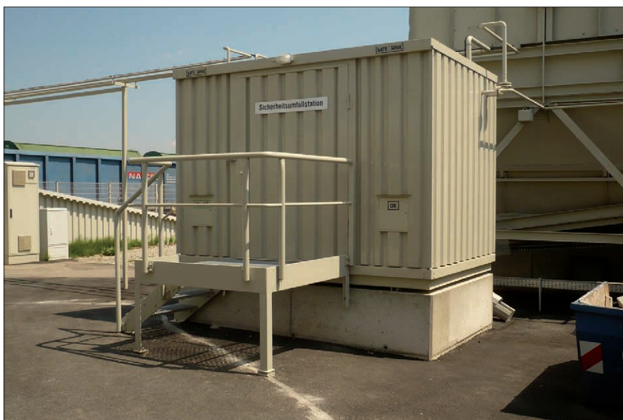
Abb. 5.7.2: Hochwassersichere Abfüllanlage für die Befüllung von Lagertanks
