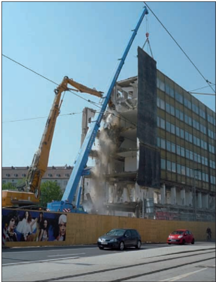
Abb. 6.12: Baustelle Abriss Lindehaus; Staubminderungsmaßnahmen
