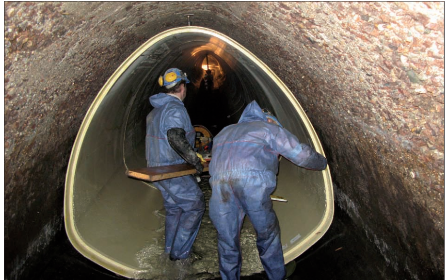
Abb. 5.5.1: Vorgefertigte Kunststoff-Segmente werden in den Altstädter Abfangkanal eingesetzt. Bei dieser Sanierungsmethode kann der Straßenverkehr auf dem Terrassenufer weiter rollen.
