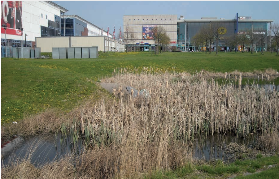
Abb. 5.2.10: Regenrückhaltebecken EKZ Elbepark
