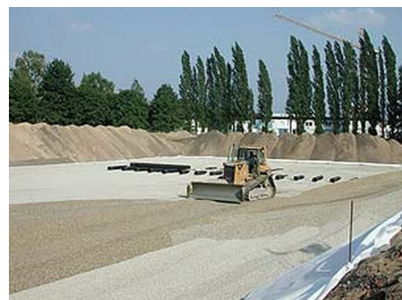
Abb. 5.18: Regenversickerungsanlage Industriestraße
