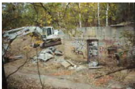
Abb. 3.10: Munitionsdepot Jägerpark: Rückbau und Renaturierung von 4,5 Hektar Asphalt und Betonfläche mit 51 Bunkern, drei Kraftwagenhallen und Nebengebäuden, ehemals mit Hochsicherheitszaun versehene Gesamtfläche: 16 Hektar.
