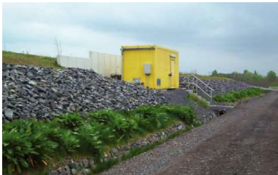
Abb. 8.12: Gasreglerstation
