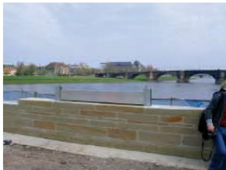
Abb. 5.25: Hochwasserschutz mit Dammbalken an der Neuen Terrasse
