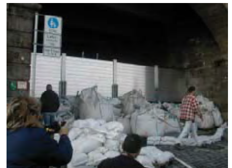
Abb. 5.24: Praxistest des mobilen Verschlusses in der Münzgasse
