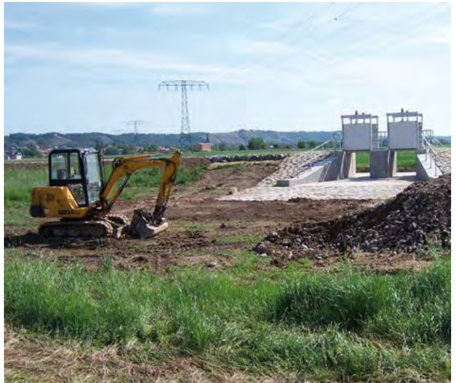
Abb. 5.34: Deichsanierungsarbeiten in Gohlis (Quelle: Landeshauptstadt Dresden)
