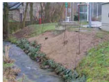
Abb. 5.6: Ingenieurbioologische Sicherung des o. g. Uferabrisses mit Uferschutzpflanzung
