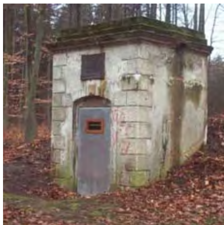
Abb. 3.4: als Fledermausquartier umgebauter Wasserspeicher am „Gänsefuß“
