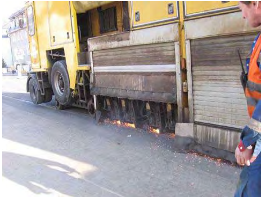
Abb. 6.12: Straßenbahngleise: Schienenschleifen mit moderner Technik
