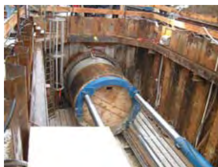
Abb. 5.46: Zweiter Bauabschnitt des Altstädter Abfangkanal Rohrvortrieb DN 2200 16. Februar 2006 (Quelle: SEDD GmbH)
