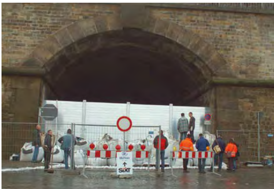
Abb. 5.31: Testaufbau des mobilen Verschlusses in der Brühlschen Gasse ; Bildquelle: Landeshauptstadt Dresden, Umweltamt, 2006.
