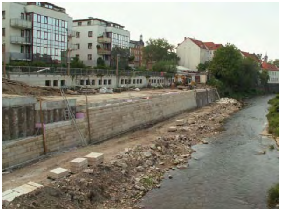
Abb. 5.28: Neubau der Ufermauer unterstrom der Brücke Oederaner Straße
