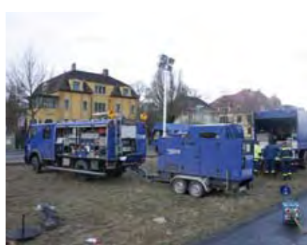
Abb. 5.45: Käthe-Kollwitz-Ufer Einsatz Technisches Hilfswerk Altstädter Abfangkanal 2. April 2006 (Quelle: SEDD GmbH)
