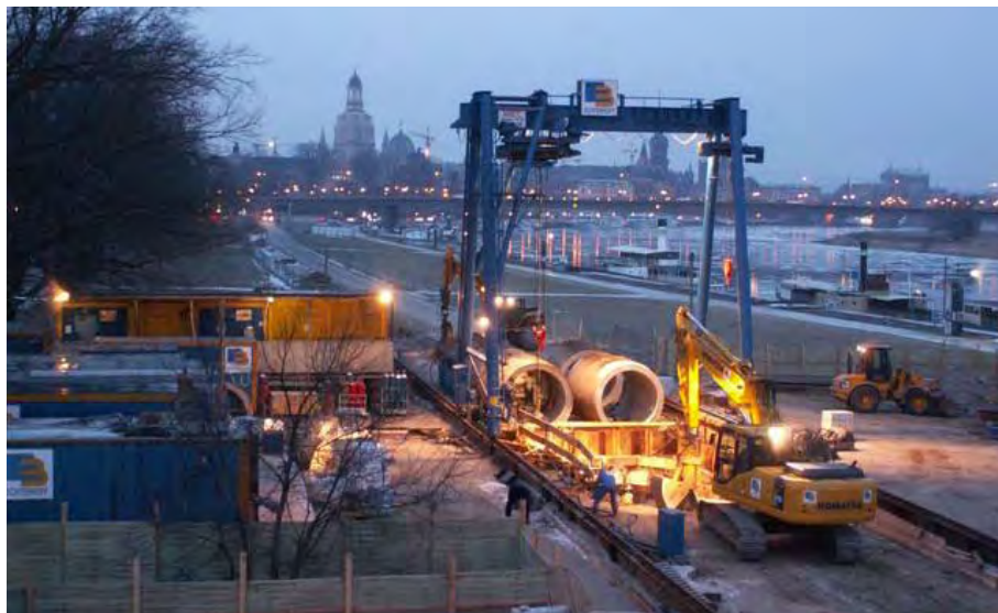
Abb. 5.18: Erneuerung des Altstädter Abfangkanals
