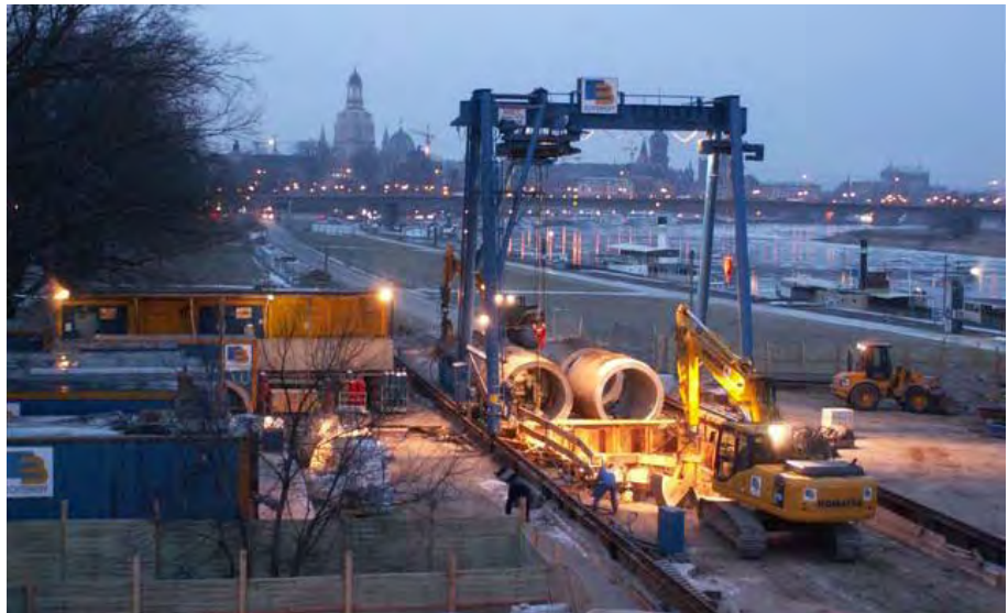
Abb. 5.18: Erneuerung des Altstädter Abfangkanals
