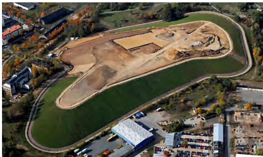
Abb. 4.12: Deponie Proschhübelstraße kurz vor dem Ende der Sanierung 2006
