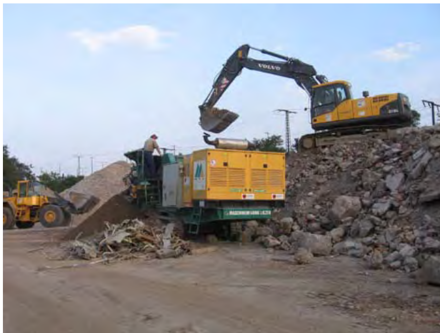
Abb. 6.8: Recyclinganlage für Bauabbruchmassen
