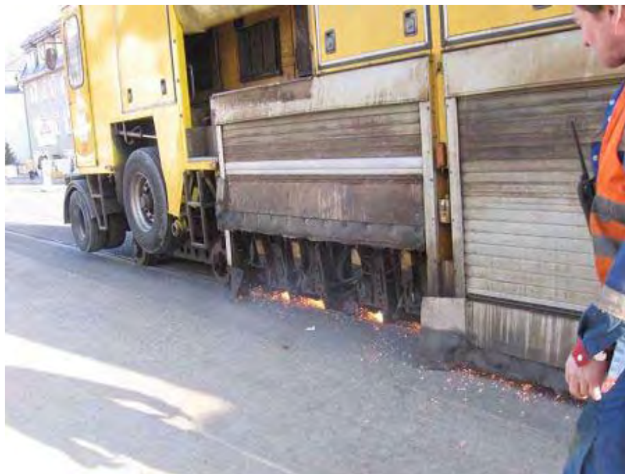
Abb. 6.12: Straßenbahngleise: Schienenschleifen mit moderner Technik
