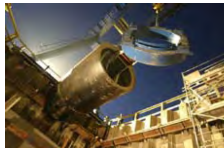
Abb. 5.17: Erneuerung des Altstädter Abfangkanals am Kongress-Center
