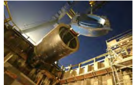
Abb. 5.17: Erneuerung des Altstädter Abfangkanals am Kongress-Center
