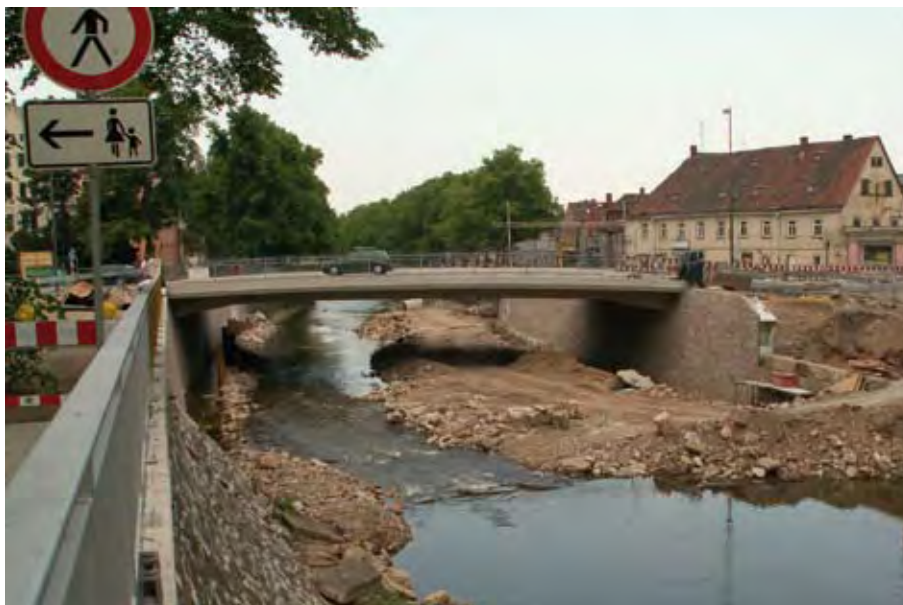
Abb.5.26: Neubau der Brücke Altplauen
