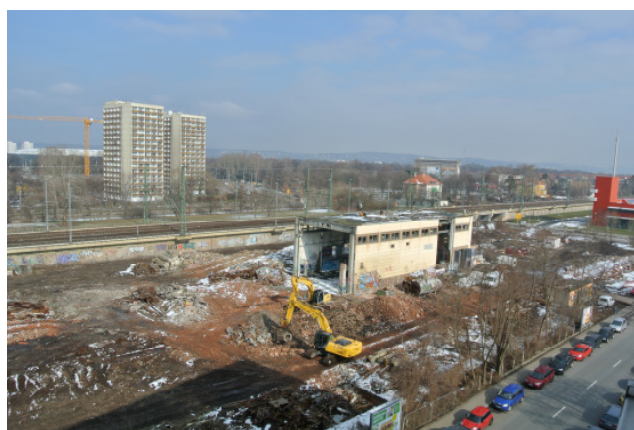
Bild 2: Abbruch der Gebäude, Januar 2013
