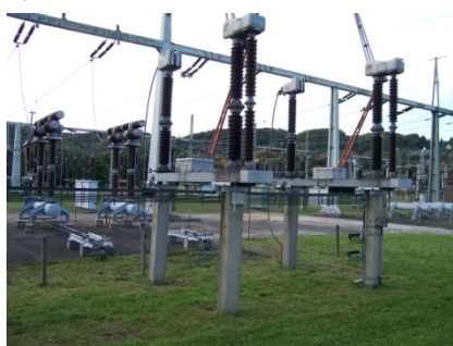
Abbildung 6.9-08: Aufgeständerte Freiluftschaltanlagen im Umspannwerk Niederwartha. Bildquelle: Landeshauptstadt Dresden, Umweltamt, 2008.
