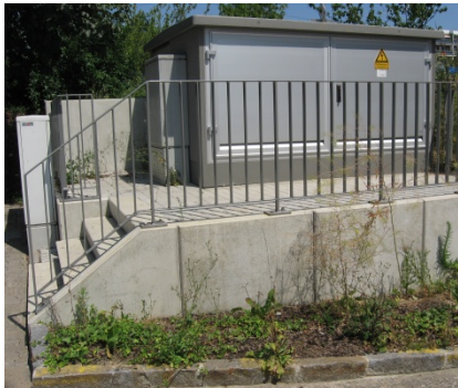
Abbildung 6.14-08: Kompakttrafostation zwischen Blockhaus und Hotel Bellevue
