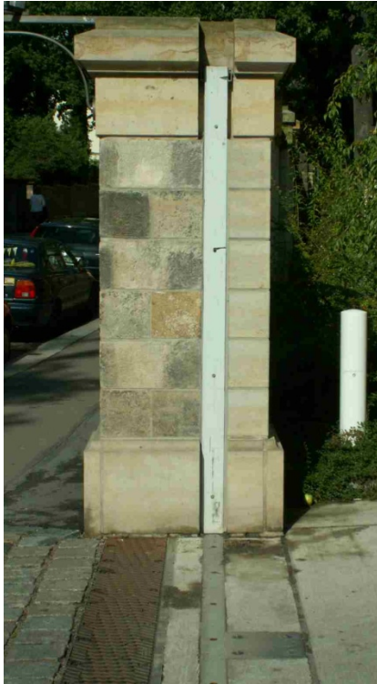
Abbildung 6.14-09: Diakonissenhausanstalt, Vorrichtungen zum mobilen Verschluss (Dambalken) einer Zufahrt; Bildquelle: Landeshauptstadt Dresden, Umweltamt, Juli 2007 Lage: rechtselbisch Strom-km 53,6 Hinweis: Das Schutzziel entspricht Durchflüssen größer HQ20, aber kleiner HQ50. Darüber hinaus besteht eine technisch nicht mehr abwendbare Gefährdung des Objekts durch Grundwasseranstieg.
