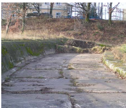
Abbildung 6.10-10: Sanierungsbedürftiges Tosbecken der Flutrinne Kaditz, Bildquelle: DDC Dorsch Consult Ingenieurgesellschaft mbH, Februar 2007
