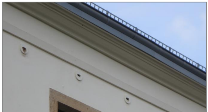
Mauerseglernistkasten in die Wärmedämmung eingebaut
