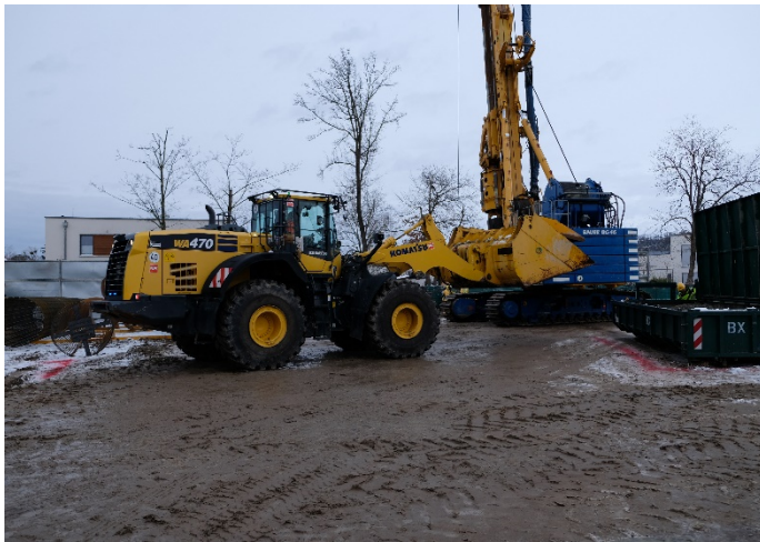
Bild 4: Bodenaustausch
