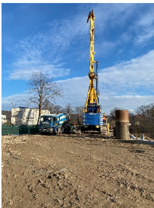
Bild 2: Abteufen der ersten Bohrung
