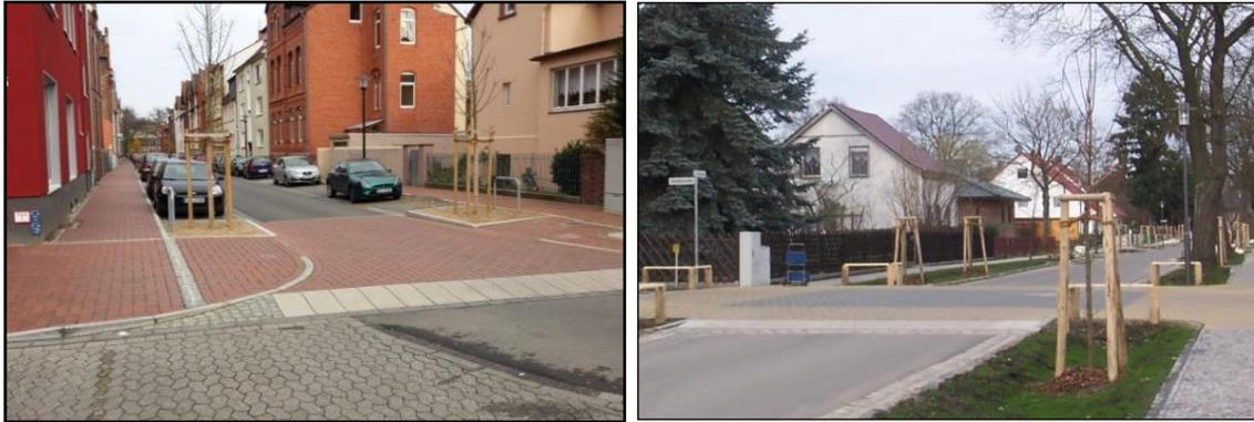
**Abb. 48** Beispiele für Gehwegüberfahrten bzw. Plateaufpflasterungen
