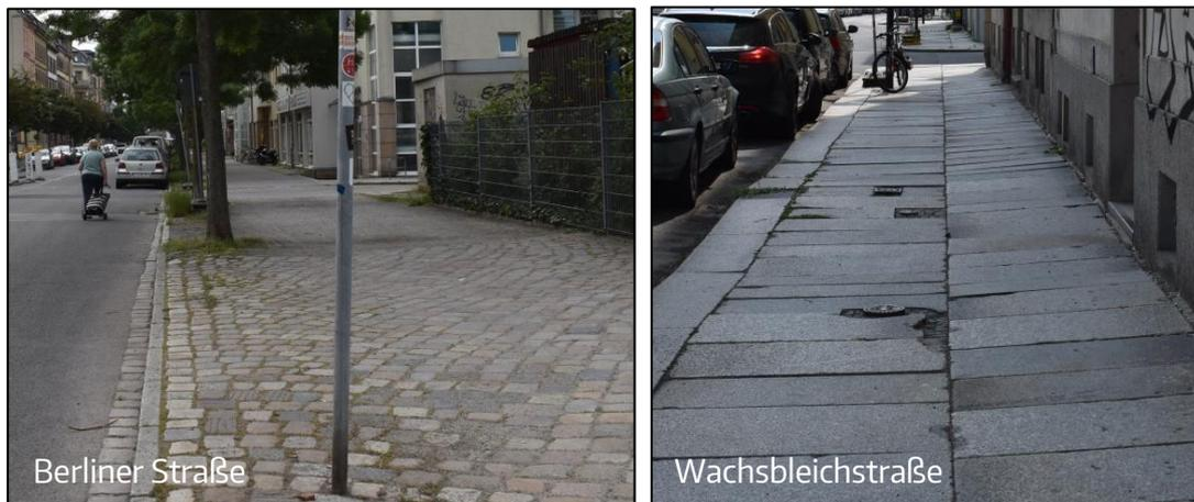
**Abb. 24** Beispiele für Oberflächendefizite im Gehwegbereich
