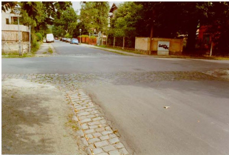
Foto: Kreuzungsbereich in Striesen mit teilweise umlaufenden Pflasterbändern
