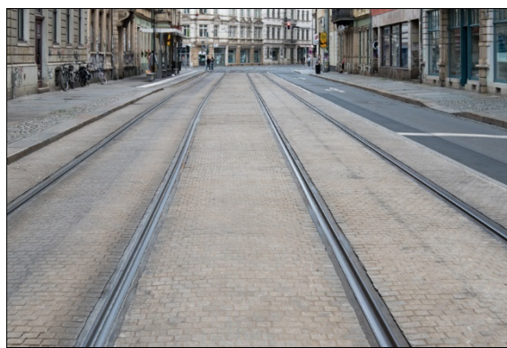
Bild 11: Gleiseindeckung in der Hoyerswerdaer Straße
