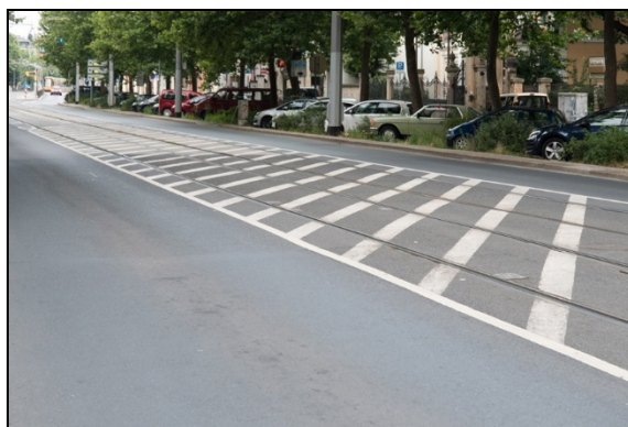
Bild 10: Gleiseindeckung in der Bautzner Straße
