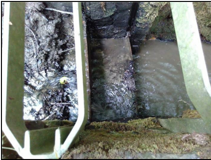
Abb. 3: Vor der Maßnahme: Ablassbauwerk Unterer Vogelgrundteich, 10.07.2020
