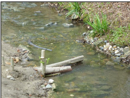
Abb. 5: Nach der Maßnahme: Baumstambühne und Kiesdepot zur Initiierung naturnaher Sohlstrukturen, 27.04.2022
