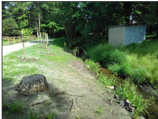
Abb. 5: Nach der Maßnahme: Uferverbau entfernt und Ufer abgeflacht, Initiierung naturnaher Strukturen durch Wurzelstöcke, Anpflanzung standortgerechter Gehölze, 15.06.2021
