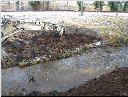
Abb. 3: Während der Maßnahme: Ingenieurbiologische Ufersicherung mit Faschinen, 11.01.2021
