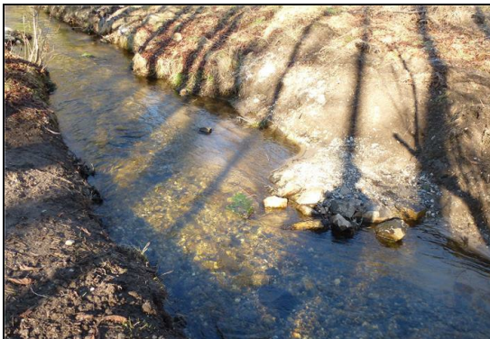
Abb. 4: Nach der Maßnahme: Initiierung von Sohl- und Uferstrukturen durch Dreiecksbuhnen, 02.03.2021
