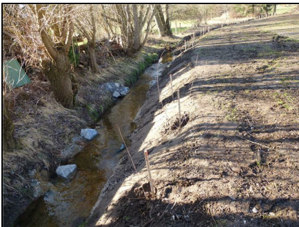
Abb. 5: Nach der Maßnahme: Naturnahe Ufer- und Sohlgestaltung mit Störsteinen und Gehölzpflanzungen, 14.02.2022
