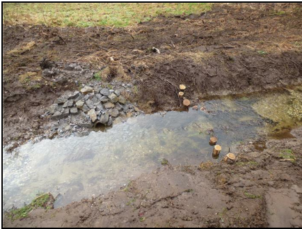
Abb. 4: Nach der Maßnahme: Einfassung Rohreinlass und Strömungstrichter, 24.01.2022
