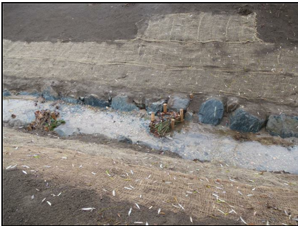
Abb. 4: Nach der Maßnahme: Faschinenbuhnen zur Initiierung einer naturnahen Sohlstruktur, 16.12.2021
