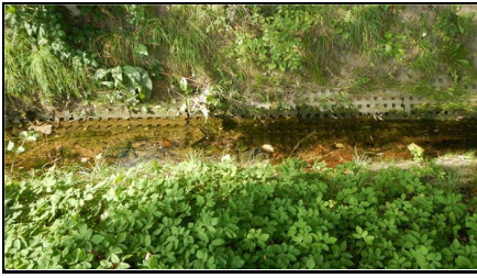
Abb. 2: Vor der Maßnahme: fester Sohlverbau mit Rasengitterplatten, 28.09.2017
