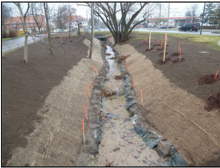
Abb. 3: Nach der Maßnahme: naturnah gestaltetes Gerinne mit standortgerechten Gehölzpflanzungen, 16.12.2021
