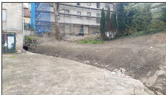
Abb. 3: Schönfelder Bach, oberster Abschnitt der Maßnahme, Blick stromauf auf Auslauf aus Verrohrung, 06.05.2022
