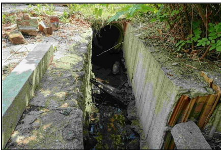
Abb. 2: GH_I-86-00521 Kurzdoku : BILD_VORSchönfelder Bach: Instandsetzung Ufer als naturnahe Böschung, 10.06.2020
