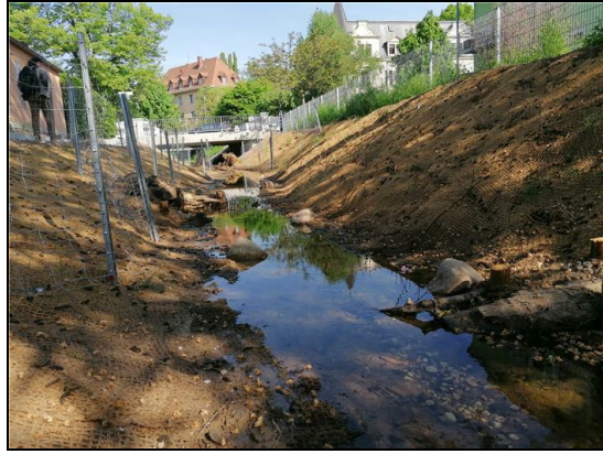
Abb. 5: nach Fertigstellung: renaturierter Gewässerabschnitt unterhalb Brücke Draesekestraße mit ingenieurb biologischen Sicherungsbauweisen und Strukturelementen, initialer Bepflanzung und Pflegeweg, 10.05.2022
