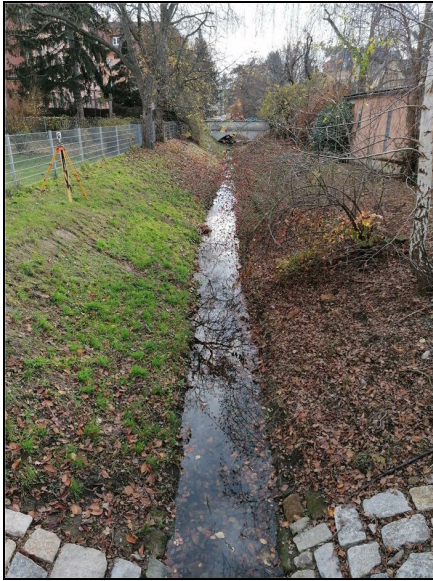
Abb. 2: vor Maßnahmebeginn: ausgepflasterter Gewässerabschnitt unterhalb Brücke Draesekestraße, 16.11.2021
