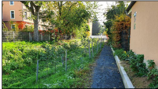
Abb. 7: Maßnahmebereich 5 Monate nach Fertigstellung, 17.10.2022
