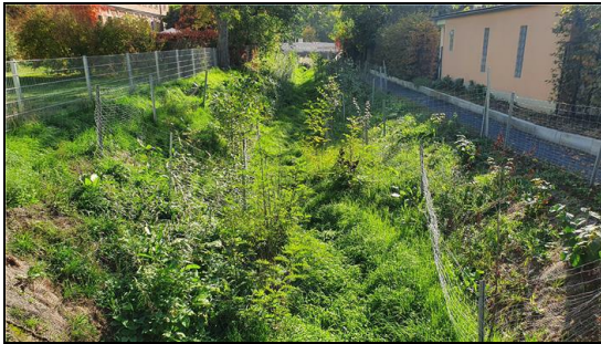
Abb. 6: Maßnahmebereich 5 Monate nach Fertigstellung, 17.10.2022
