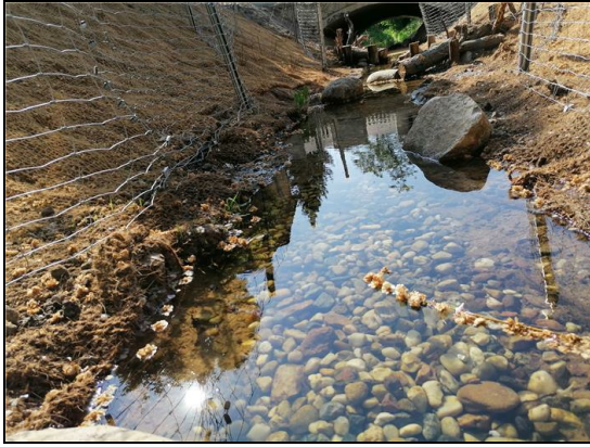
Abb. 4: unmittelbar nach Fertigstellung: strukturreicher Sohl- und Mittelwasserbereich, 10.05.2022
