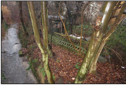
Abb. 2: BA1: Verbaute Ufer und Sohle (IST-Zustand), 18.01.2014
