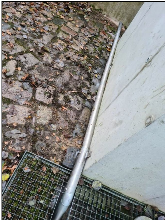
Abb. 3: Drucksondenrohr im Sockelbereich, 01.12.2022
