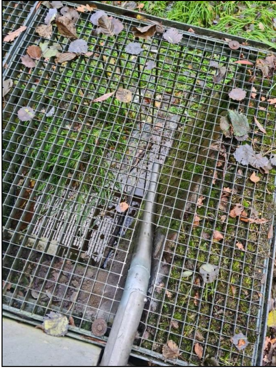
Abb. 5: Drucksondenrohr im Rechenbereich, 01.12.2022
