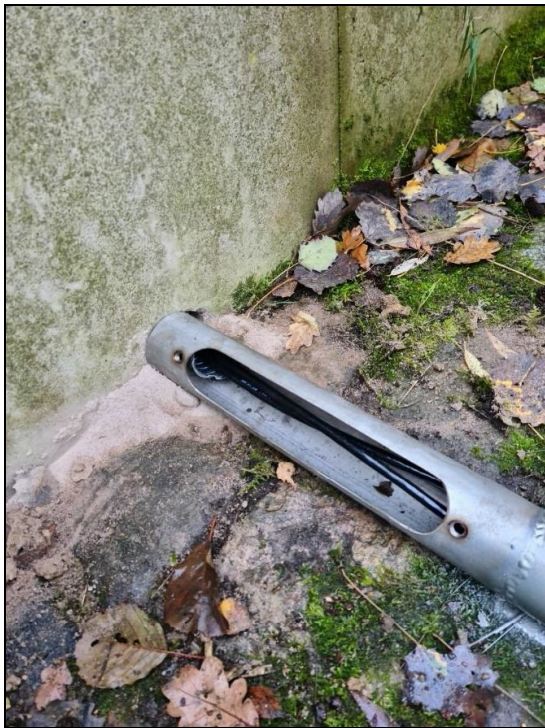
Abb. 4: Drucksondenrohr im Sockelbereich, Detail, 01.12.2022
