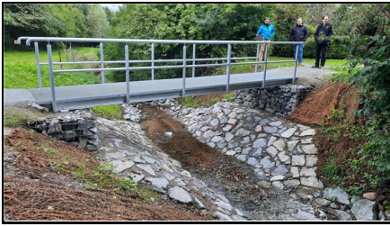
Abb. 3: Brücke nach Fertigstellung, 16.09.2022
