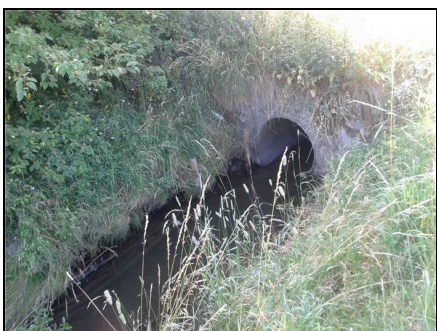
Abb. 1: Blick in den bestehenden Rohrdurchlass, 02.07.2015
