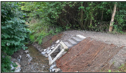
Abb. 4: Abschlag zu den Marienteichen nach Fertigstellung, 16.09.2022
