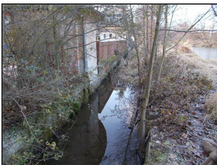
Abb. 1: vor der Maßnahme: Lockwitz Mühlgraben Bereich Ablauf Dankelmannteich, Blick stromauf, 16.12.2016
