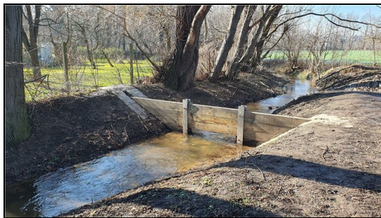
Abb. 5: nach Fertigstellung: neu errichtetes Zulaufwehr am Lockwitzmühlgraben, 02.03.2023
