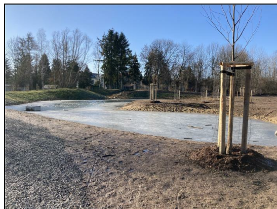
Abb. 8: nach Fertigstellung: neu angelegter Teich und Freianlagen im Bereich Mühlenstraße, 15.02.2023
