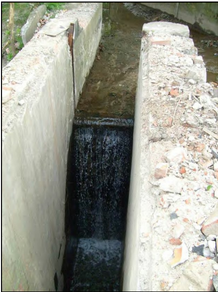
Abb. 3: vor der Maßnahme: Sohlabsturz im Bereich ehem. Dankelmannteiche, 01.06.2018
