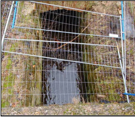
Abb. 2: vor der Maßnahme: Zulauf zur Überdeckung/Verrohrung, 01.06.2018
