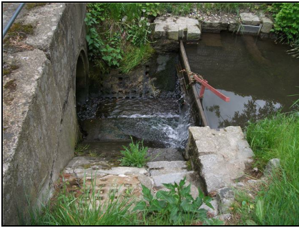
Abb. 2: Vor der Maßnahme: Wehr oberstrom des Durchlasses Kugelgenweg, 16.05.2012
