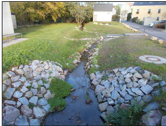
Abb. 6: Nach der Maßnahme: Schelsbach unterhalb Kugelgenweg, Blick stromab, 26.10.2022
