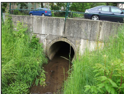
Abb. 1: Vor der Maßnahme: Durchlass Kugelgenweg, 16.05.2012
