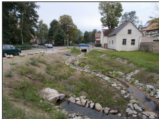
Abb. 7: Nach der Maßnahme: Schelsbach unterhalb Kugelgenweg, Blick stromauf, 06.09.2022
