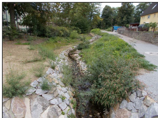
Abb. 9: Nach der Maßnahme: Schelsbach oberhalb Kugelgenweg, Blick stromauf, 06.09.2022
