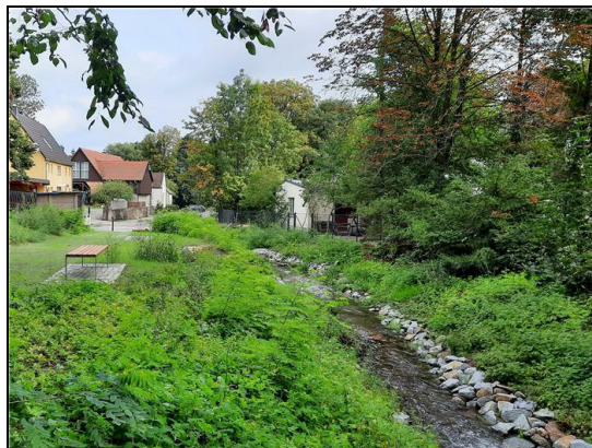
Abb. 8: Nach der Maßnahme: Schelsbach oberhalb Kugelgenweg, Blick stromab, 15.09.2022
