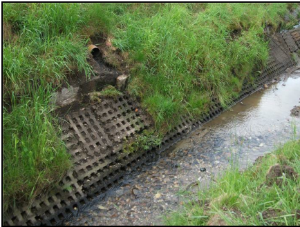
Abb. 3: Vor der Maßnahme: Ufer- und Sohlverbau aus Rasengitterplatten, 16.05.2012
