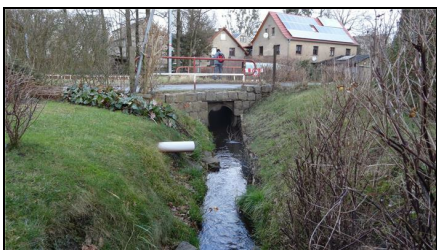
Abb. 1: Vor der Maßnahme: Blick stromab auf Durchlass Böhmler Straße oberstrom Alte Schmiede, 30.01.2018
