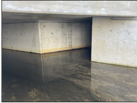
Abb. 7: Wiedereinmündung des Umfluters in den Schullwitzbach in Brücke B033500 im Bau, 10.05.2021
