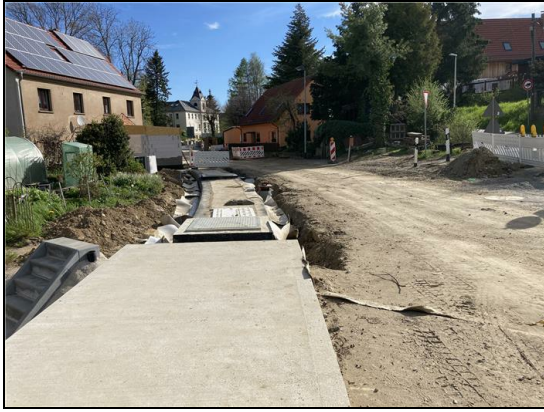
Abb. 6: Umfluter Schullwitzbach im Bau, Blick stromab, 10.05.2021
