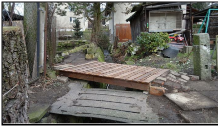
Abb. 2: Vor der Maßnahme: Schullwitzbach oberstrom Alte Schmiede, Blick stromab, 30.01.2018
