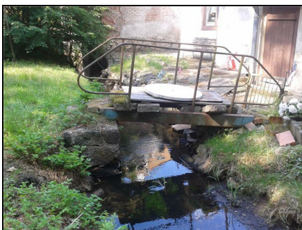
Abb. 1: Private Brücke über den Lausenbach (IST-Zustand), 04.07.2017
