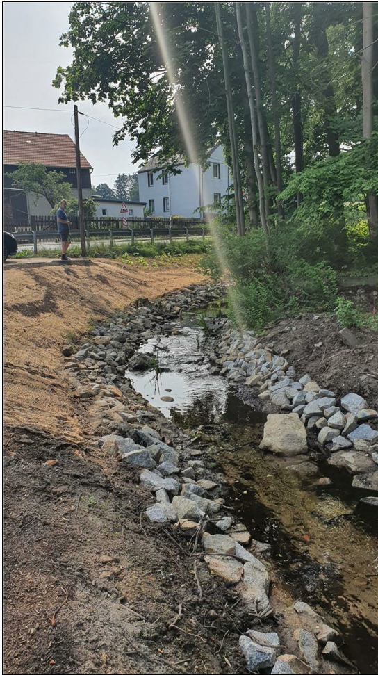
Abb. 6: umgestalteter Lausenbach bei der VOB-Abnahme, 16.06.2021
