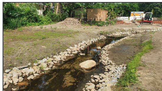
Abb. 5: umgestalteter Lausenbach bei der VOB-Abnahme, 16.06.2021
