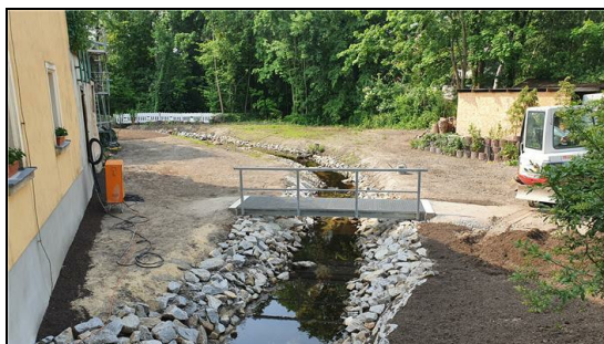
Abb. 4: umgestalteter Lausenbach bei der VOB-Abnahme, 16.06.2021
