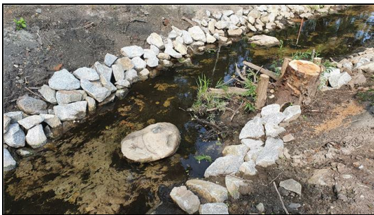
Abb. 8: umgestalteter Lausenbach bei der VOB-Abnahme, Detail Gewässersohle, 16.06.2021
